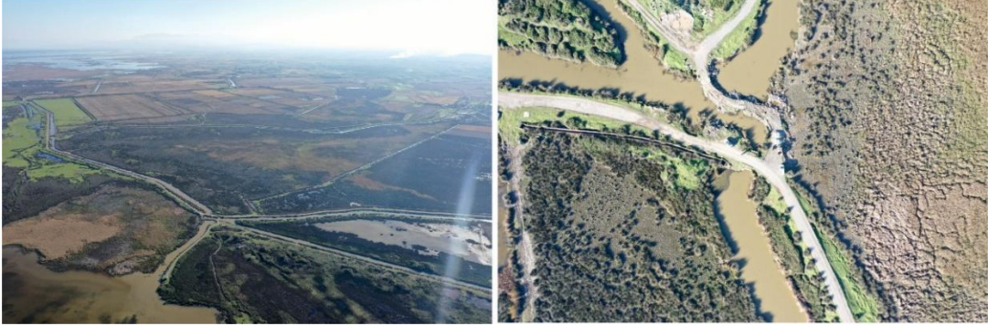
Şekil 2.7: Delta düzlüğündeki drenaj kanalları.
