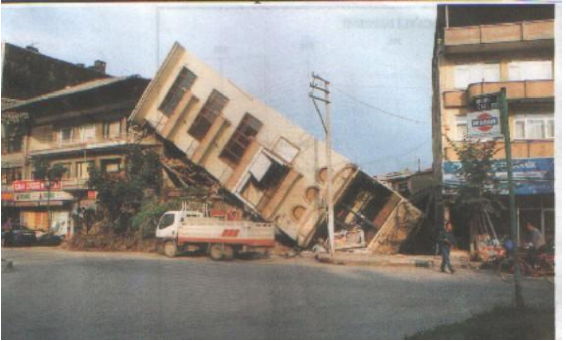
Resim 1.3. Sıvılaşma, Adapazarı
