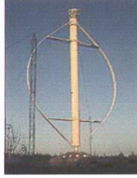
Şekil 3.10. Eole- C Darrieus Rüzgar Türbini Destek Sistemi
