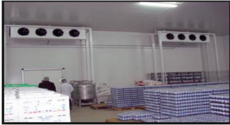
řekil 3.3: Yođurt ve süt üretim- depolama tesislerinde paslanmaz elik borulu ısı deđerliřtiricilerinin kullanımına örnek.
