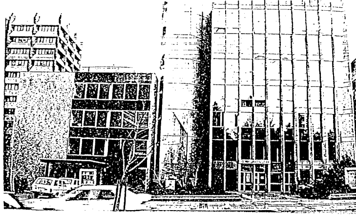
Resim 3.14. Türk Dil Kurumu Binası, Cengiz Bektaş, Ankara.
