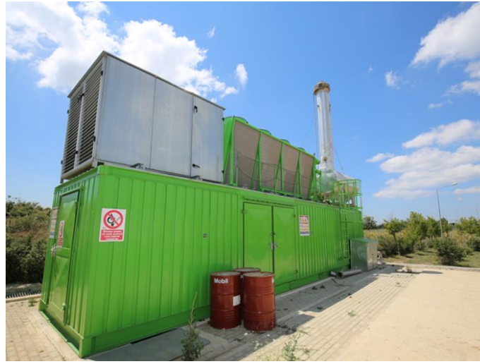
Şekil 5.2: Depo Gazından (LFG) Enerji Üretimi [WEB-42].
