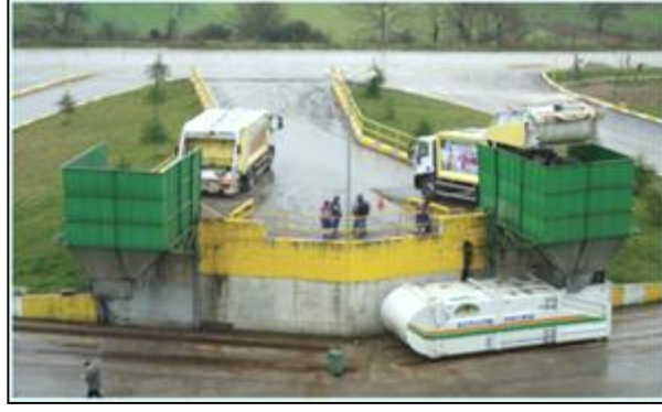
Şekil 3.5: Kandıra katı atık aktarma istasyonu.
