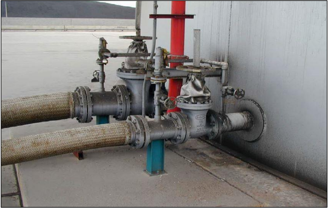
Şekil 2.9: Korozyona ve zamana bağlı deformasyonlara dayanıklı esnek borular ve bağlantı elemanları.
