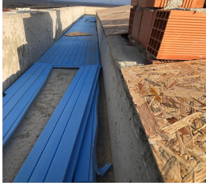
Şekil 4.15: Kayabaşı Toki konutları çatıda dere izolasyonu uygulaması [Toki Arşiv, 2024].
