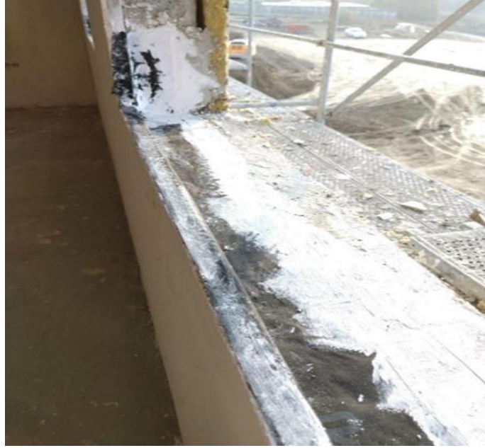
Şekil 4.17: Kayabaşı Toki Projesi pencere etrafı yalıtım uygulaması [Toki Arşiv, 2024].
