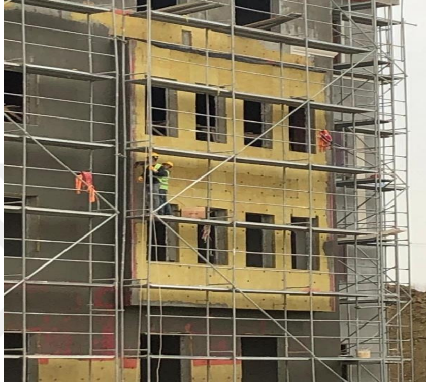
Şekil 4.14: Kayabaşı Toki konutları dış cephe taş yünü mantolama uygulaması [Toki Arşiv, 2024].
