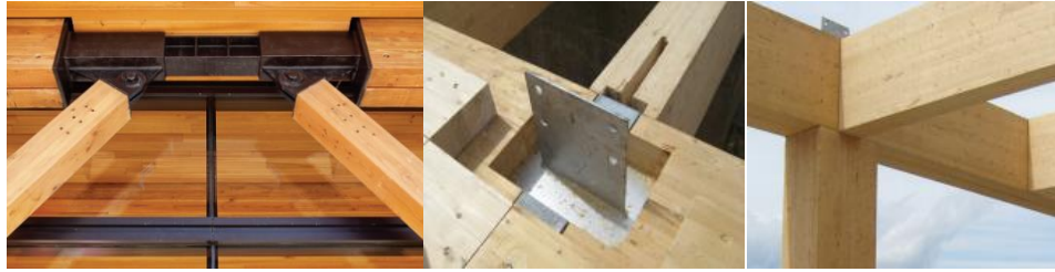
Şekil 3.4: Yüksek ahşap yapılardaki birleşim örnekleri [1].
