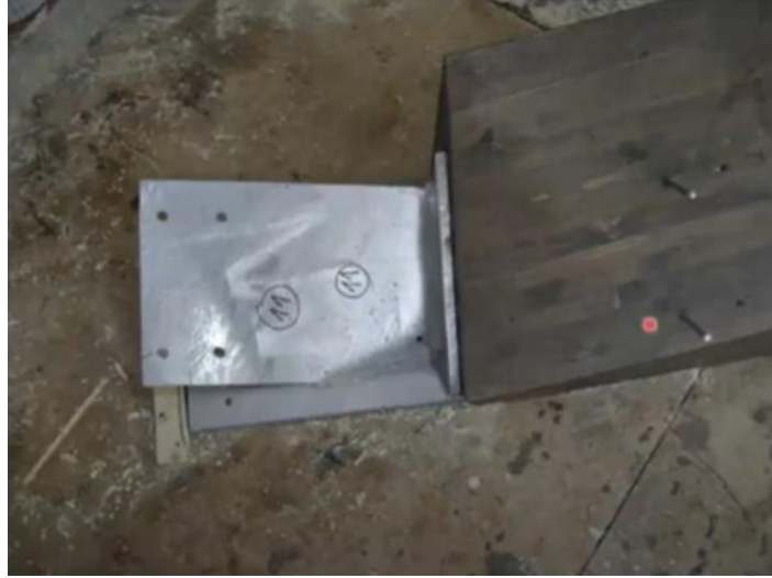
Şekil 3.35: Nevmekân Sahil yapı kubbesine ait bağlantı detayı [68].
