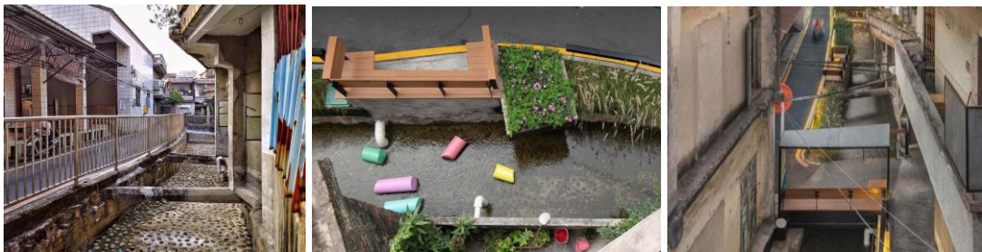
Şekil 4.72: Longjin Nehri düzenlemeleri (solda) ve Longjin Su Köşkü (sağda) [Yuxing Zhang, 2020; Yu Bai, 2020].
