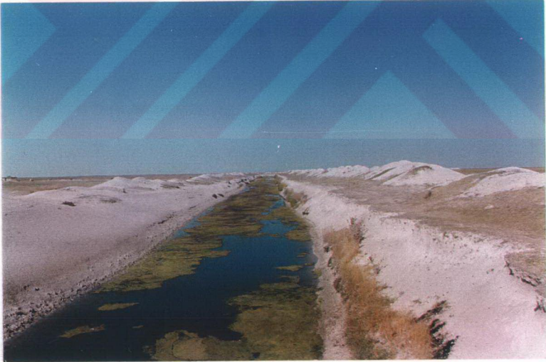
Şekil 4.1. Gölyazı Mevkiinde Ana Tahliye Kanalı'nın Görünümü
