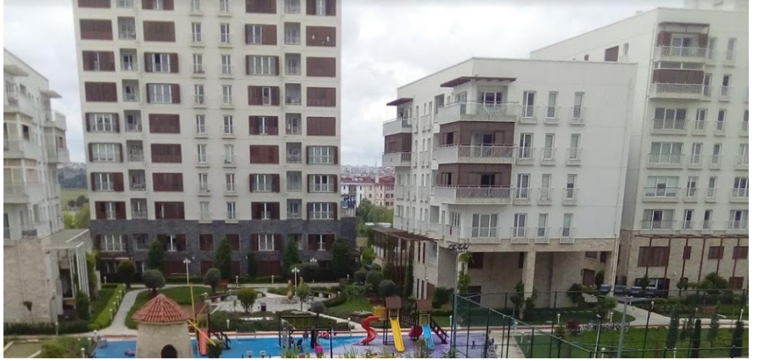
Şekil 5.24: Cephede Kullanılan Güneş Kontrol Elemanları.
