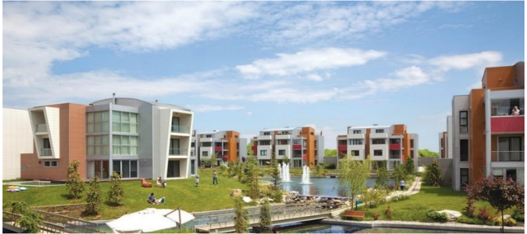
Şekil 5.13: Yapıların Sırdam Yüzeyleri.
