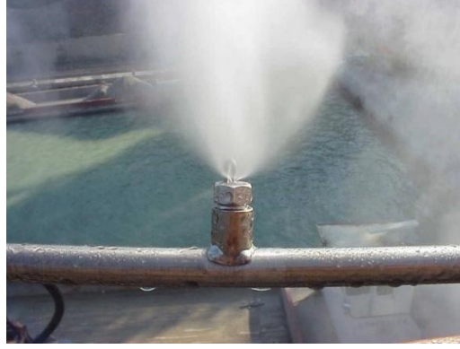
Şekil 4.2: Blur Building su püskürtme nozulu detayı [Web, 15].
