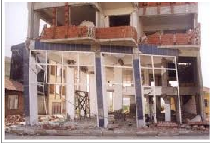
Şekil 2.7: Yumuşak kat oluşumu.
