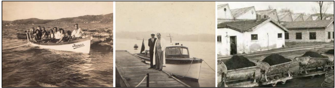
Şekil 5.21: Beykoz Kundura ve Deri Fabrikası özgün kullanımında ulaşım.
