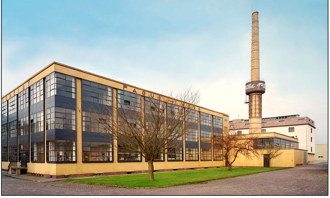
Şekil 2.4: Fagus Factory in Alfeld dış mekân görüntüsü.
