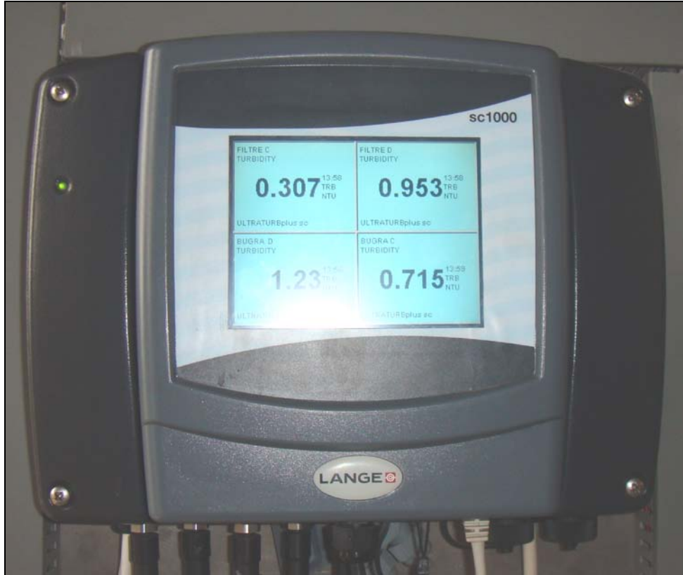
Şekil 4.12. Bulanıklık ve parçacık sayısı değişimlerinin sürekli olarak izlendiği gösterge cihazı
