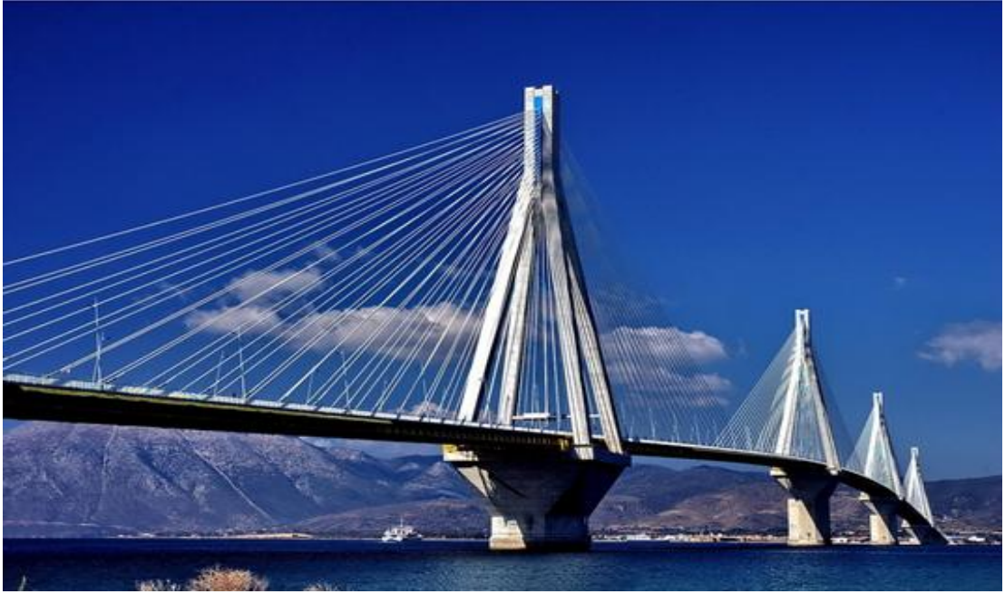
Şekil 2.30. Rion-Antirion Köprüsü [Eğriboyun, 2008].
