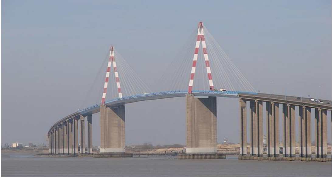
Şekil 2.14. Saint Nazaire Köprüsü [Eğriboyun, 2008].
