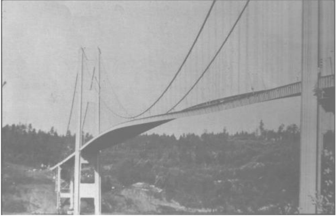
Şekil 2.33. Rüzgar Etkisi Altında Burulan Köprü Tabliyesi (Takoma Narrows Asma Köprüsü) [ Boduroğlu, 2007].
