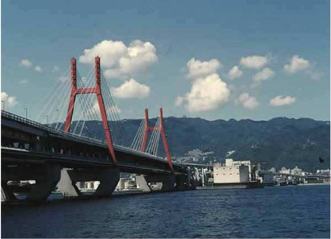
Şekil 2.20. Rokko Köprüsü [Eğriboyun, 2008].
