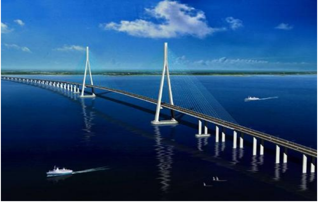
Şekil 2.28. Sutong Köprüsü [Janjic, 2008]
