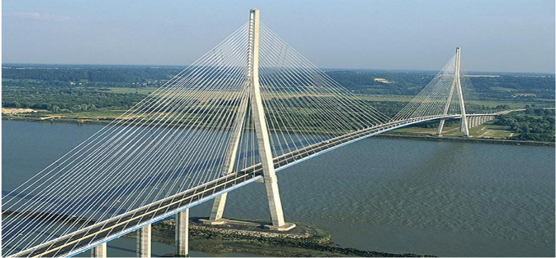
Şekil 2.25. Normandia Köprüsü [Eğriboyun, 2008].
