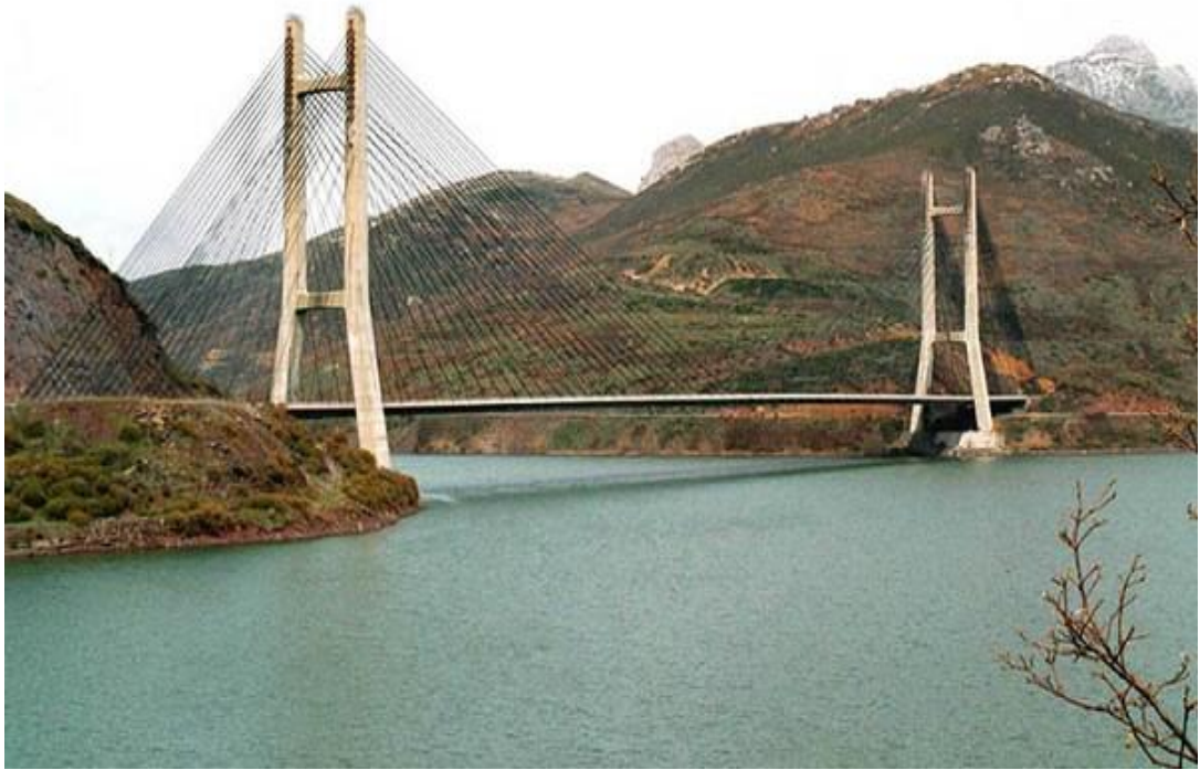
Şekil 2.19. Barrios De Luna Köprüsü [Eğriboyun, 2008].
