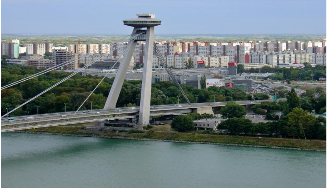
Şekil 2.16. Danube Kanal Köprüsü [Eğriboyun, 2008].
