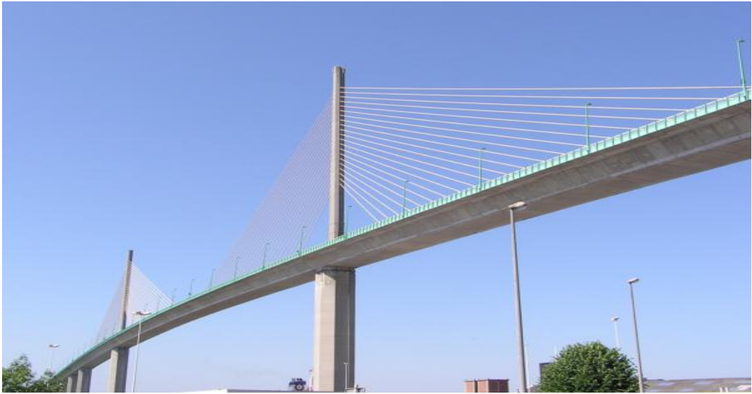
Şekil 2.17. Brotonne Köprüsü [Eğriboyun, 2008].
