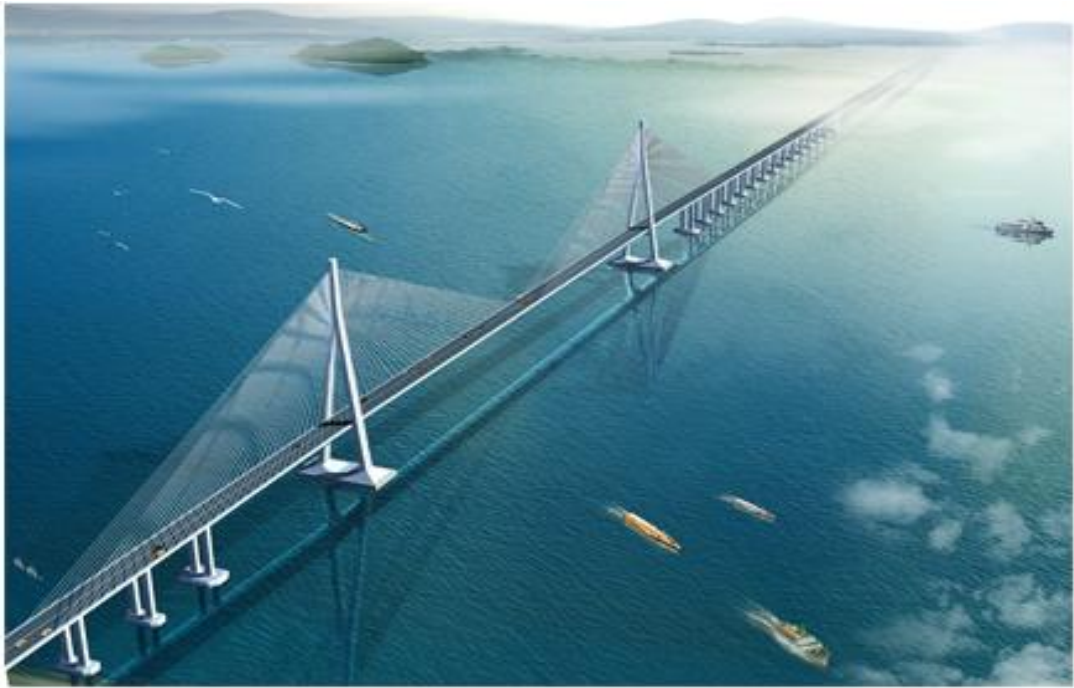
Şekil 3.1. Sutong Köprüsü [Janjic, 2008].
