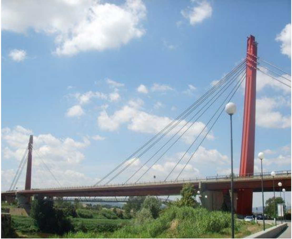
Şekil 2.15. Indiano Köprüsü [Eğriboyun, 2008].
