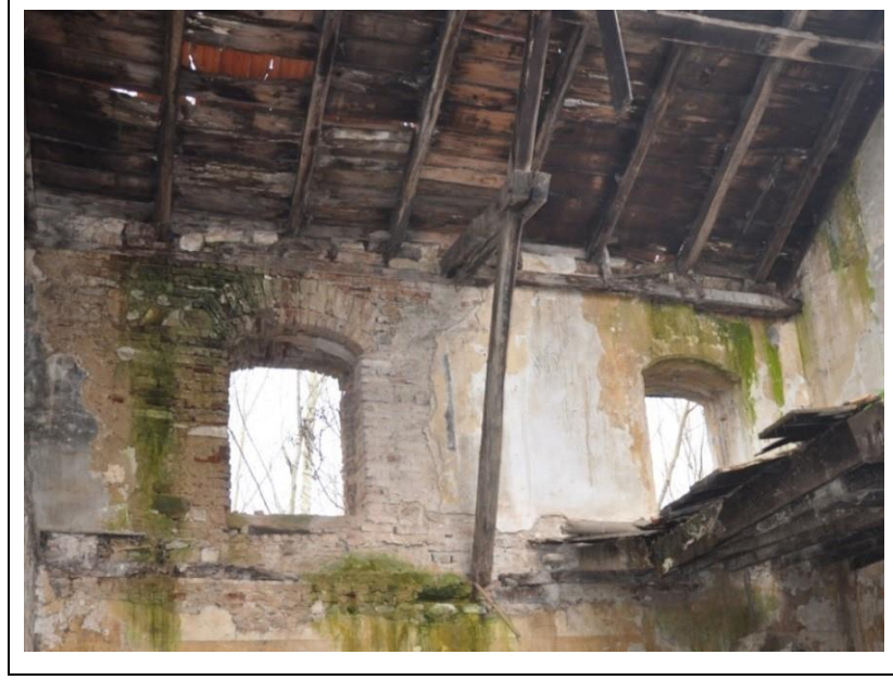
Şekil 4.18: 1-01 nolu mekânın batı duvarı (2018).
