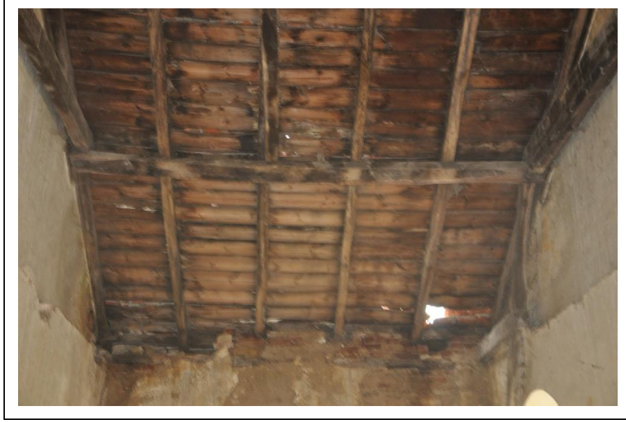
Şekil 4.47: Çatıya ait mertek, ara aşık ve çatı kiremit altı kaplaması.
