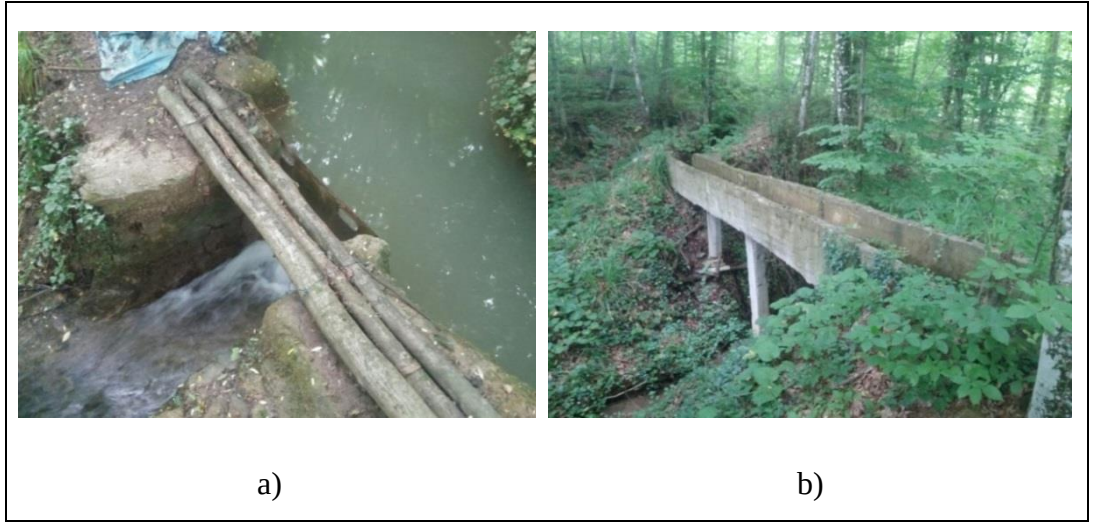
Şekil 5.2: a) Tali arka ait metal su savağı, b) Su arkına ait betonarme köprü.
