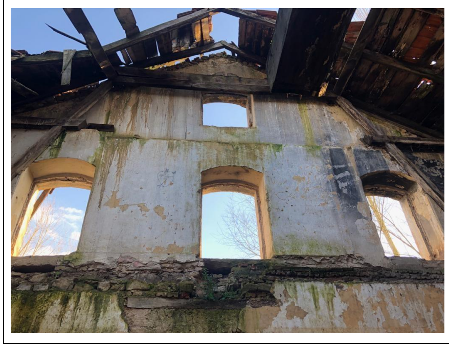
Şekil 4.16: 1-01 nolu mekânın güney duvarı (2018).
