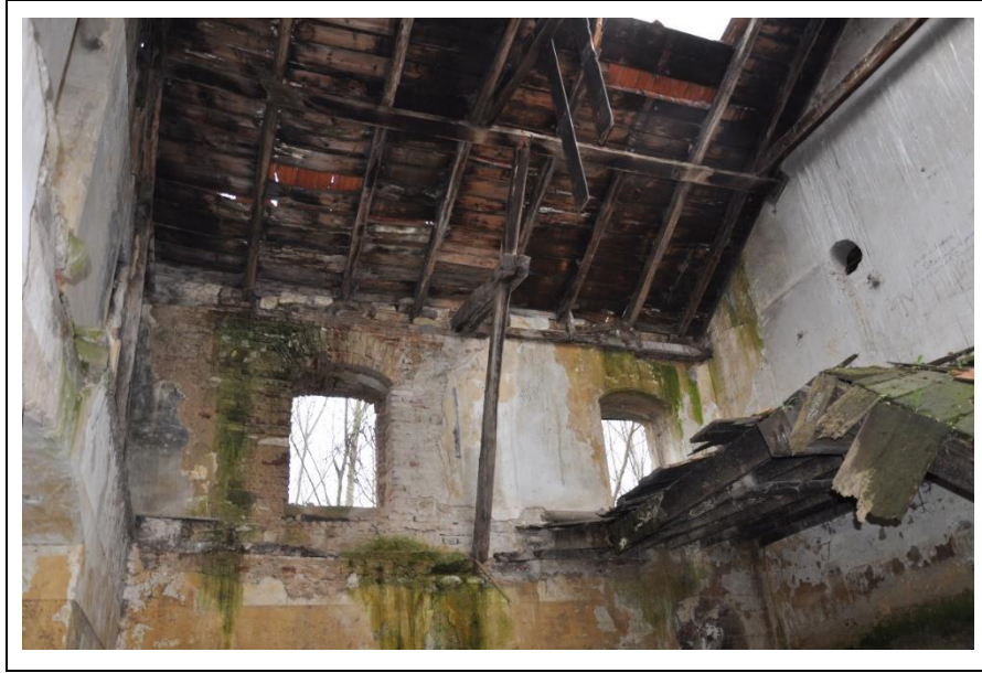
Şekil 4.46: Çatı strüktüne ait gergi kirişi ve yanlama destek ahşapları.
