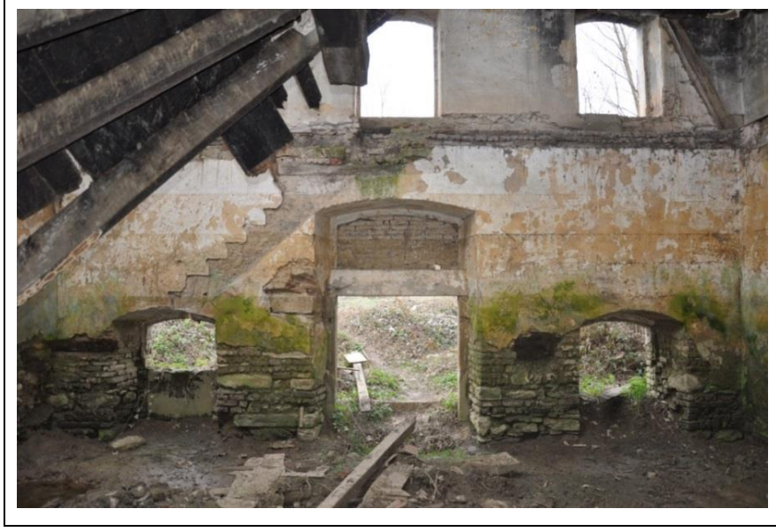
Şekil 4.7: Z-01 nolu mekânın güney duvarındaki ana giriş kapısı ve merdiven izi (2018).
