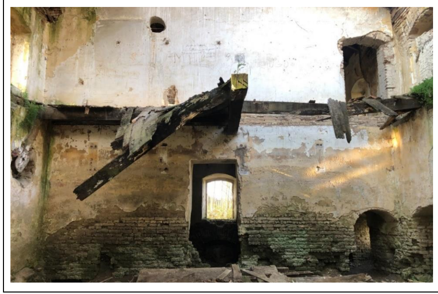
Şekil 4.10: Z-01 nolu mekânının kuzey duvarı (2018).
