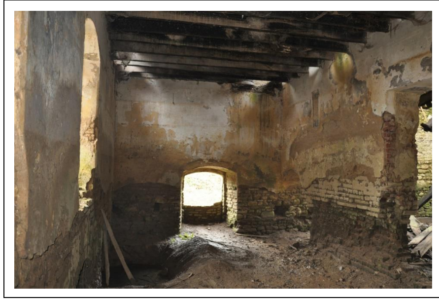
Şekil 4.14: Z-02 nolu mekânının güney ve doğu duvarı (2018).
