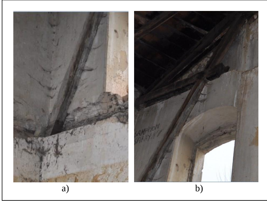
Şekil 4.17: a) 1-01 nolu mekânın güney duvarı ilk yanlama destek kademesi, b) 1-01 nolu mekânın güney duvarı ikinci gergi kirişi kademesi (2018).
