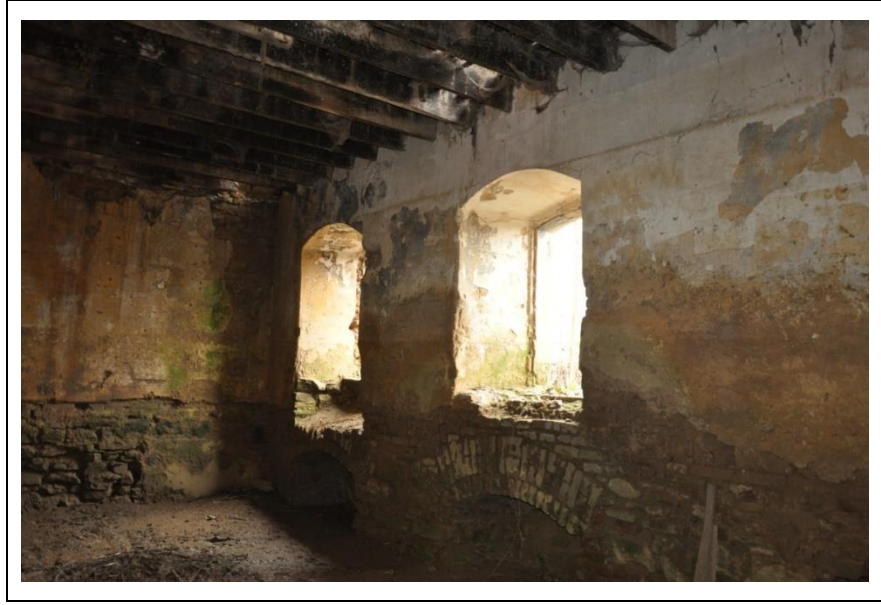
Şekil 4.13: Z-02 nolu mekânının kuzey duvarı (2018).
