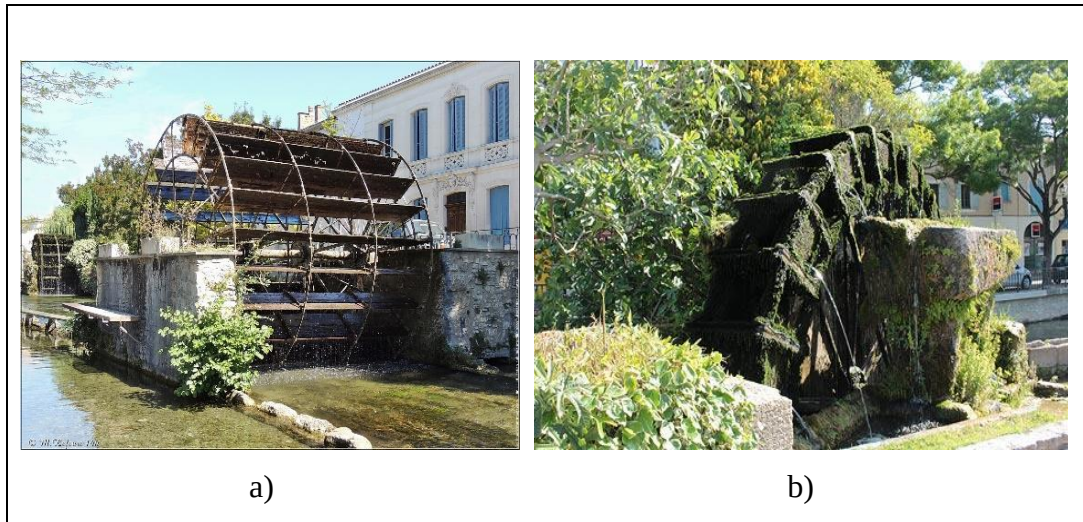
Şekil 3.21: a) Güney Fransa, Province Bölgesi, yatay milli göğüslemeli düşey su çarkı örneği, b) Province Bölgesi yatay milli göğüslemeli düşey su çarkı örneği.
