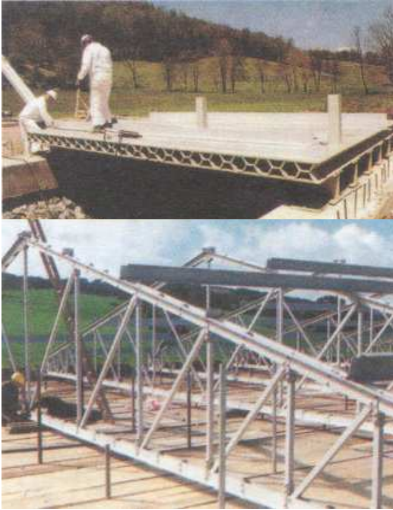
Şekil 3.4. CTP köprü tabliyesi ve çatı makası uygulamaları.
