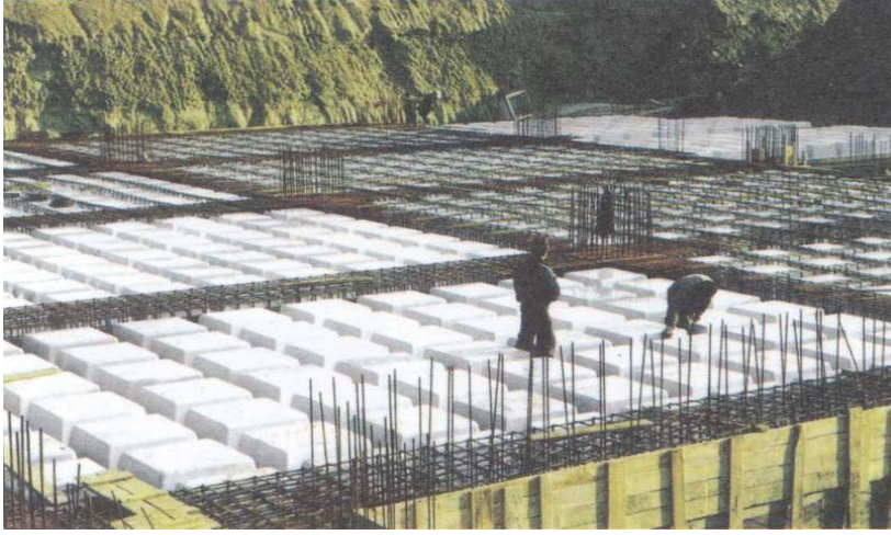
Şekil 3.3. Kaset döşeme kalıp uygulaması.
