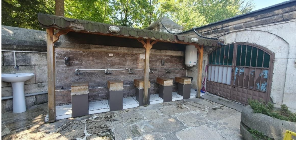
Şekil 3.49: Şehzade Mehmed Camii erkek abdesthanesi, 2024.
