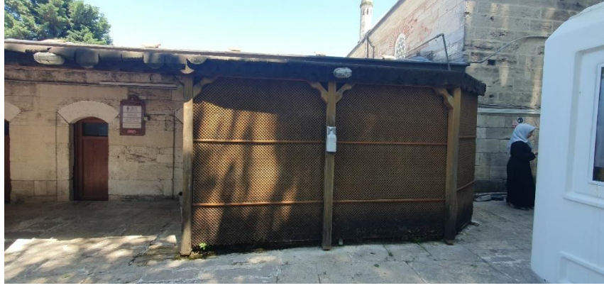
Şekil 3.61: Şehzade Mehmet C. kadınlar abdesthanesi bölmesi dış görünüm, 2024.
