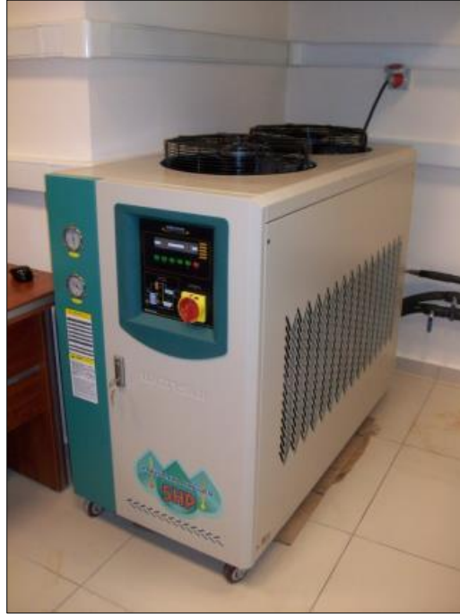
Şekil 3.5: Kalıp soğutma ünitesi.
