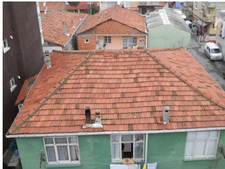
Şekil 4.7: Fikirtepe'deki alan çalışmasına ait kiremit çatı örtüsü.
