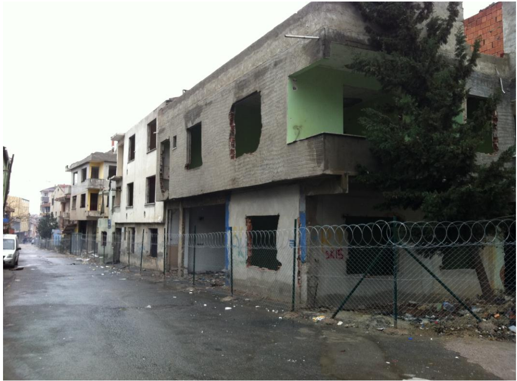
Şekil 4.5: Fikirtepe’deki alan çalışmasına ait tuğla duvar kalınlığı.
