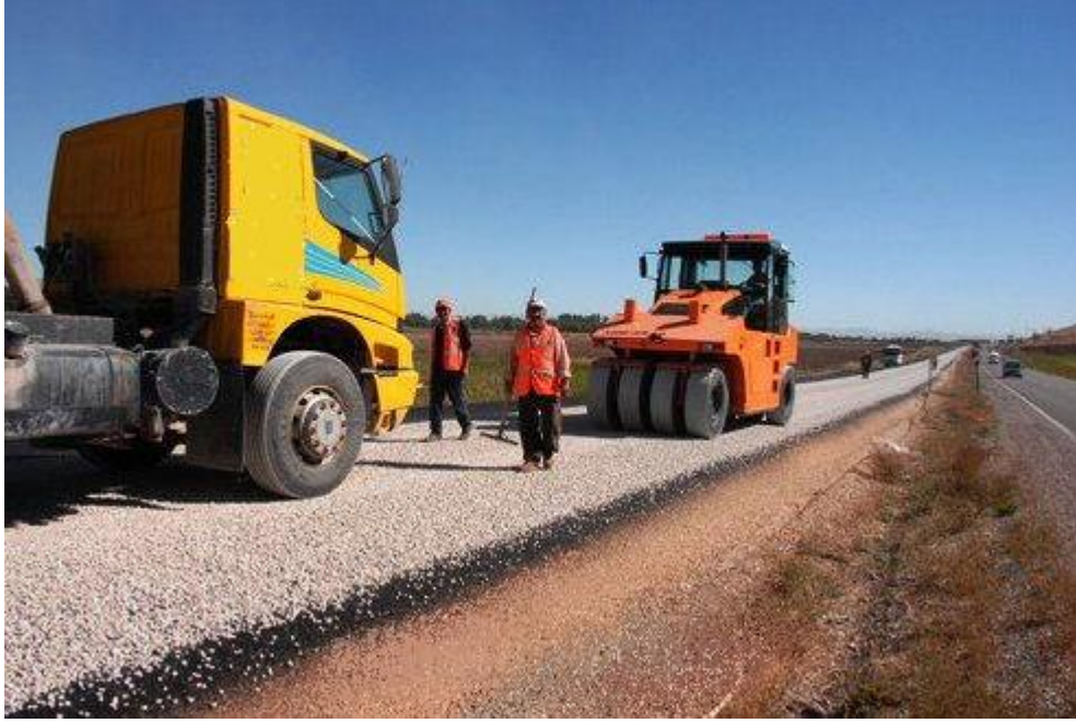
Şekil 2.2: Beton atıklarından üretilen asfalt ve mıcır uygulaması.
