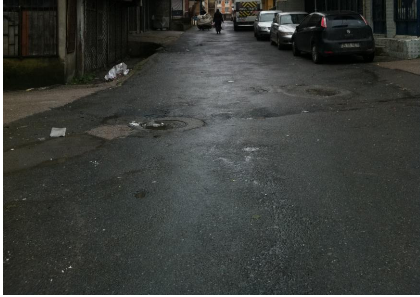
Şekil 4.6: Fikirtepe'deki alan çalışmasına ait asfalt yollar.
