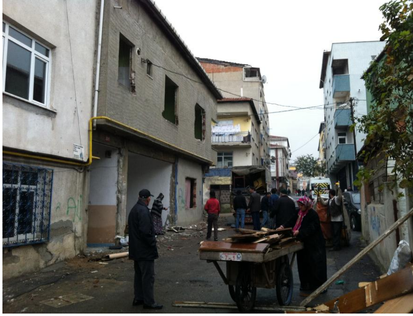
Şekil 4.11: Çalışma alanı içerisinde hurdacılar tarafından binaların yapısal atıklarının ayrıştırılması.
