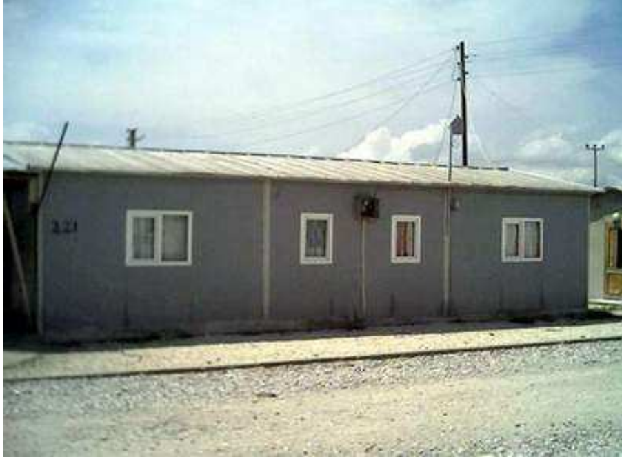
Fotoğraf 5.5 Gümüşpınar Geçici Deprem Konutun Görünüşü
