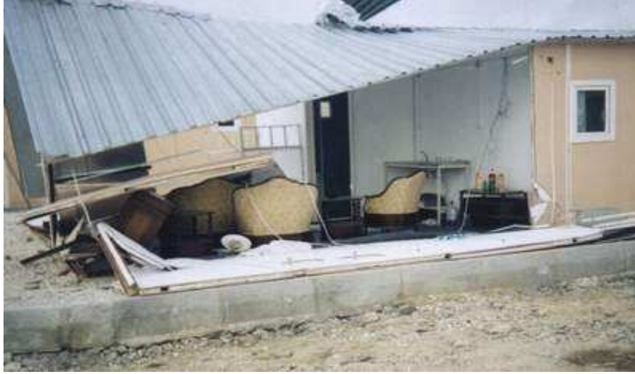
Fotoğraf 5.9 Rüzgar Yükünün Geçici Konuta Etkisi
