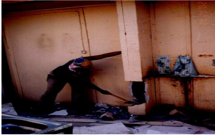
Fotoğraf 5.11 Uygun Olmayan Aletlerle Yapılan Söküm Çalışması
