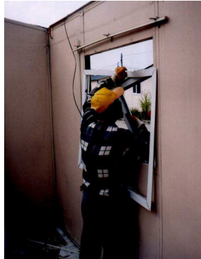
(8) Yapı Elemanlarının Sökümü
