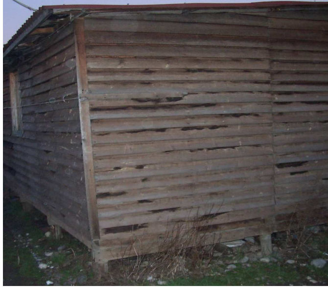
Fotoğraf 2.1 Ahşap İskelet Sistemle Yapılmış Geçici Konut Örneği
