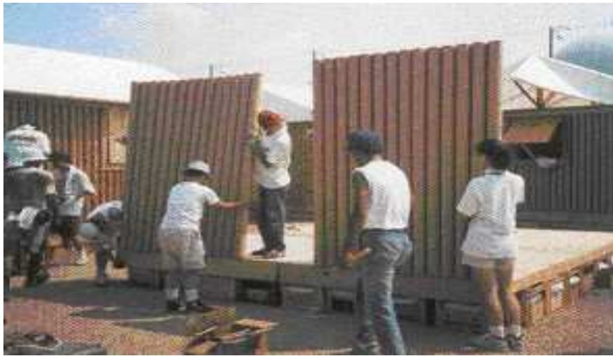
Fotoğraf 2.4 Kağıt Ev Düşey Eleman Montajı (Deprem mimarlığı, 2001)
