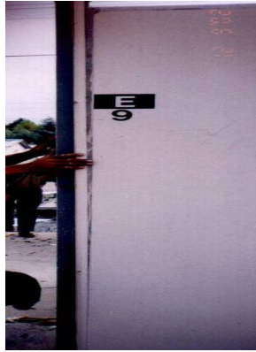
(5) Köşe profilinin Sökülmesi
