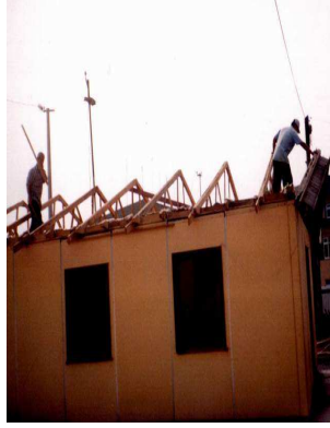
(1) Çatının Söküm Çalışmaları
