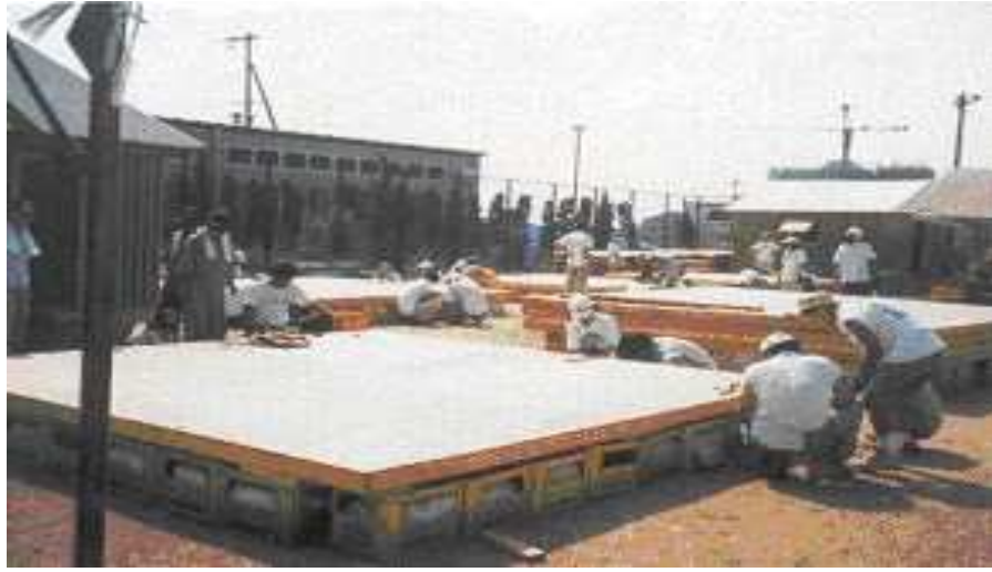
Fotoğraf 2.3 Kağıt Ev Tabanının Yapımı (Deprem mimarlığı, 2001)
