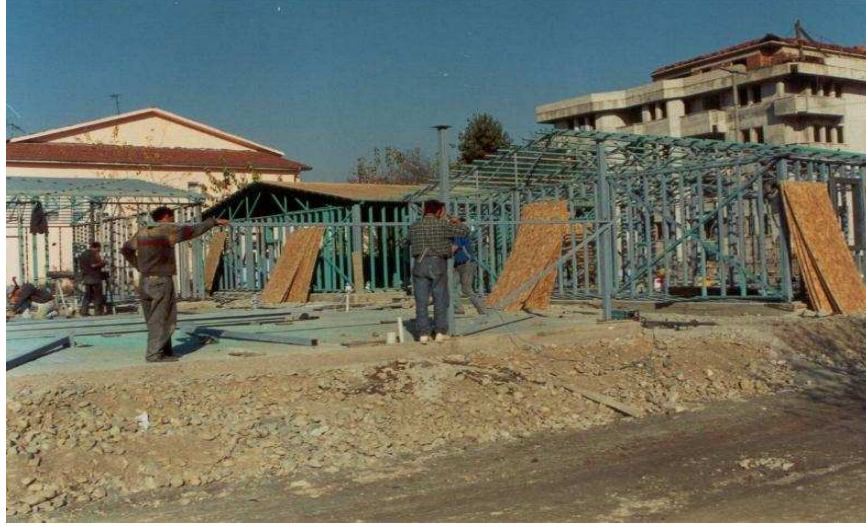
Fotoğraf 2.2 Çelik İskelet Sistemin Yapım Çalışmaları
