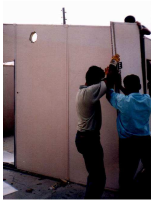
(6) Köşe Panellerin Çıkarılması
