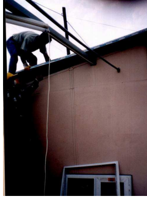
(2) Çatı Panellerinin Sökümü
