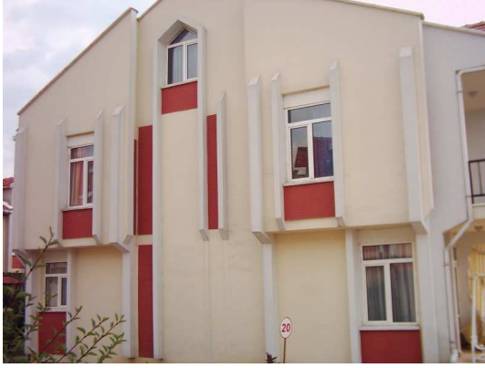
Resim 3.61. Cephelerde kullanılan yerel kırmızı tuğla ve silikon esaslı boya.
