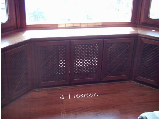
Resim 3.20. İnsan sağlığı açısından olumsuz olan radyatör önü kapamaları.
