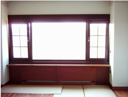
Resim 3.18. İnsan sağlığı açısından olumsuz olan radyatör önü kapamaları.
