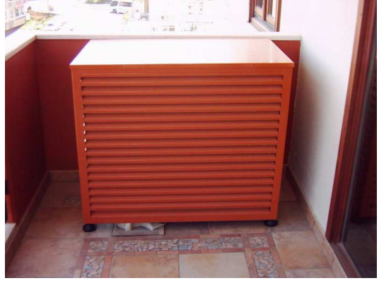
Resim 3.23. Görsel konfor açısından olumlu klima dış ünitesi.
