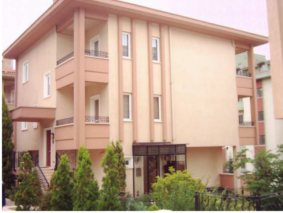
Resim 3.9. Bakım kolaylığı sağlayan yalın cephe.
