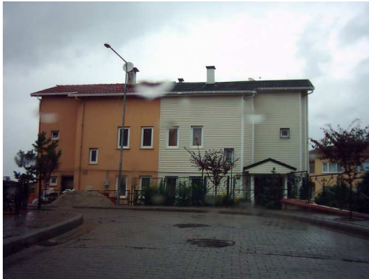
Resim 3.65. Bazı kullanıcıların tercih ettiği PVC cephe kaplaması.
