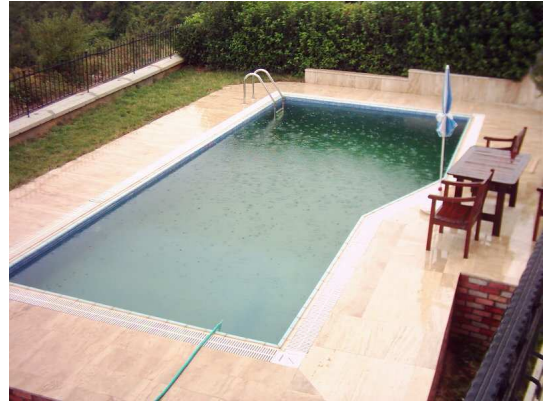
Resim 3.112. Havuz etrafında kullanılan yerel traverten, malzeme.
