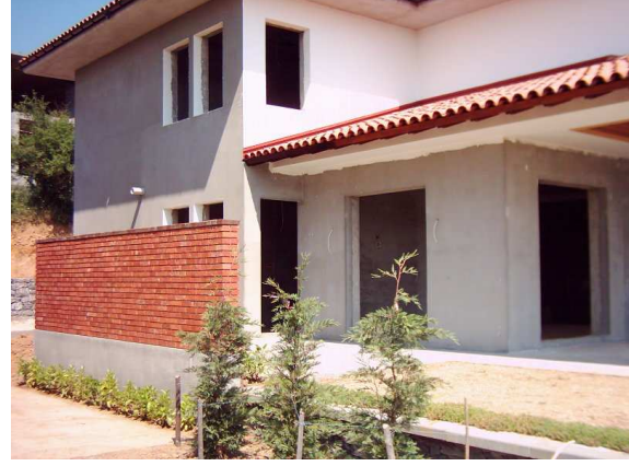
Resim 3.99. Duvarlarda kullanılan yerel, ısı yalıtımlı izo tuğla.
