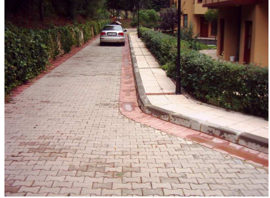
Resim 3.122. Araç yollarında kullanılan uzun ömürlü kilitli parke taşı.
