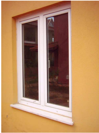
Resim 3.139. Pencere, çift camlı, doğramalar yerli PVC malzeme.
