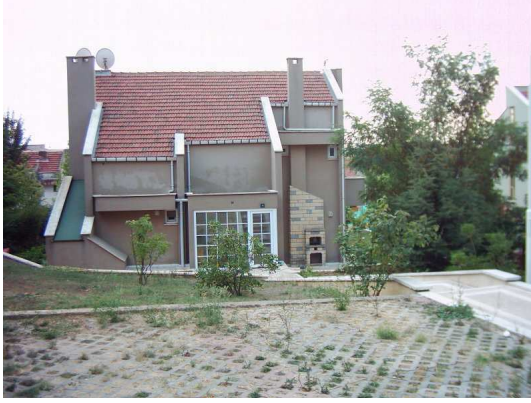
Resim 3.129. Yağmur suyu korunumu sağlayan beton esaslı çim parke taşı.
