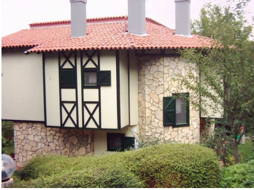
Resim 3.115. Cephede kullanılan yerli doğal taş ve dış cephe boyası.
