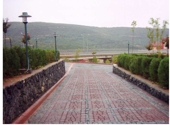
Resim 3.57. Çevre düzenlemede kullanılan hazır beton plak ve kilitli parke.
