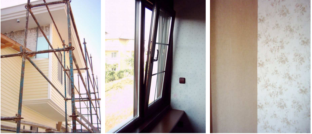
Resim 3.13. Dış cephede enerji korunumu sağlayan sert köpük uygulaması.
