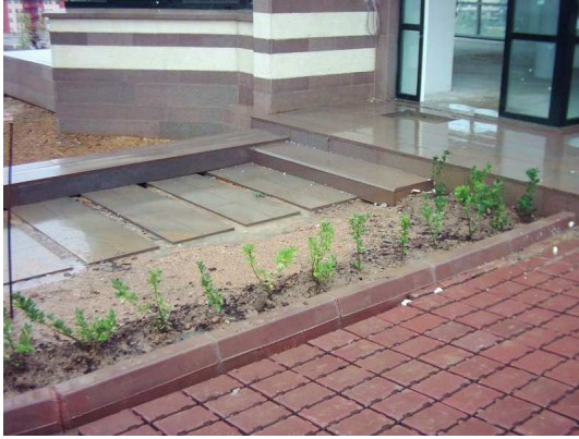
Resim 3.57. Çevre düzenlemede kullanılan hazır beton plak ve kilitli parke.
