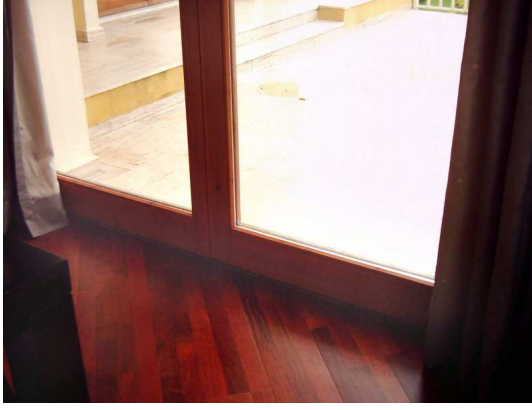
Resim 3.83. Isı yalıtımı açısından olumlu ahşap doğramalar.
