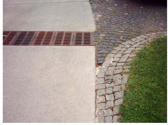
Resim 3.90. Araç yollarında kullanılan beton plak ve doğal taş.
