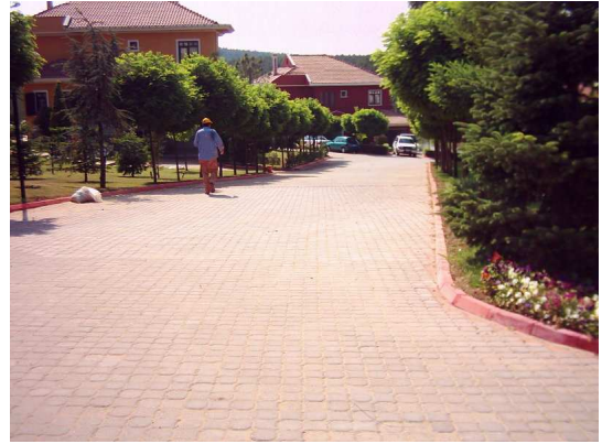
Resim 3.72. Araç yollarında kullanılan beton parke taşları.
