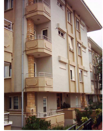
Resim 3.124. Yeterli doğal aydınlatma sağlayan pencere boşlukları.
