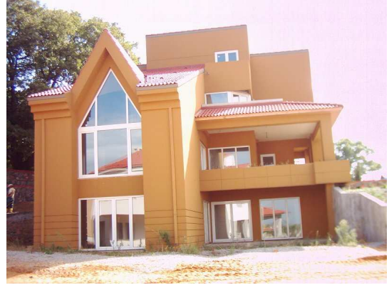
Resim 3.81. Güney cephesinde küçük tutulan pencere boşlukları.
