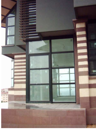
Resim 3.55. Pencerelerde kullanılan ithal PVC doğrama.
