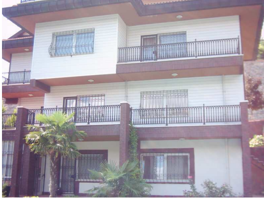
Resim 3.3. Cephede kullanılan ahşap kaplama.
