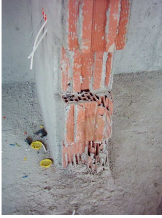
Resim 3.99. Duvarlarda kullanılan yerel, ısı yalıtımlı izo tuğla.
