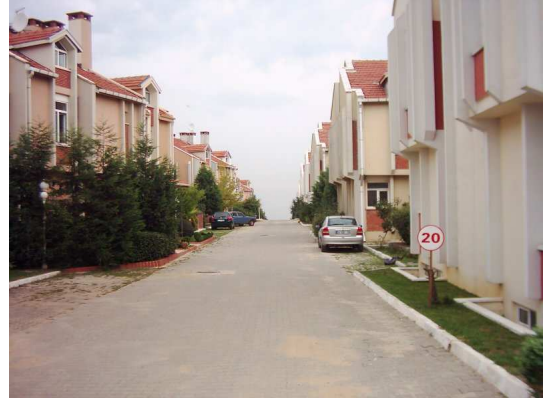
Resim 3.61. Cephelerde kullanılan yerel kırmızı tuğla ve silikon esaslı boya.
