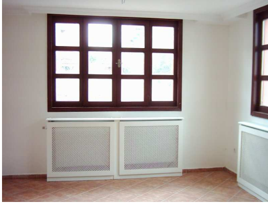
Resim 3.28. Uçucu organik bileşik yayılımını arttıran radyatör önü kapamaları.
