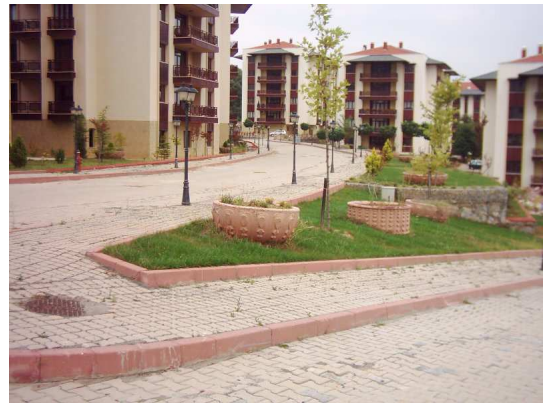
Resim 3.106. Araç yollarında kullanılan yerel ve uzun ömürlü kilitli parke.
