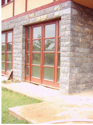
Resim 3.119. Pencereelerde kullanılan yerel ahşap doğrama ile doğal taş kaplama.
