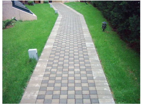
Resim 3.54. Yürüme yolunda kullanılan yerel beton parke.
