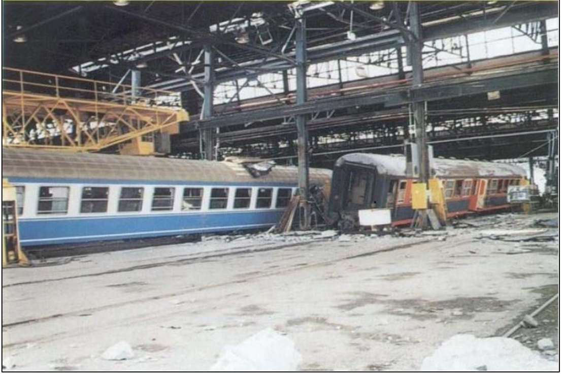
Şekil 3. 1: Adapazarı Tüvasaş krenli endüstri vagon fabrikası hasar.
