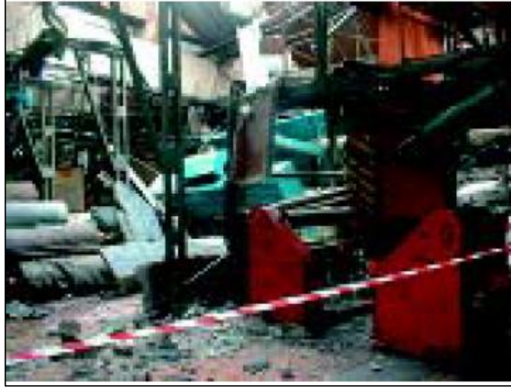
Şekil 2.1: İzmit’de üretimin uzun süreli durmasına sebep olan kısmi göçmüş endüstriyel tekerlek fabrikası.
