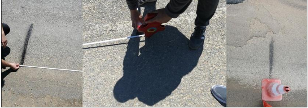
Şekil 3.14: Test yolunun ölçülmesi ve işaretlenmesi.
