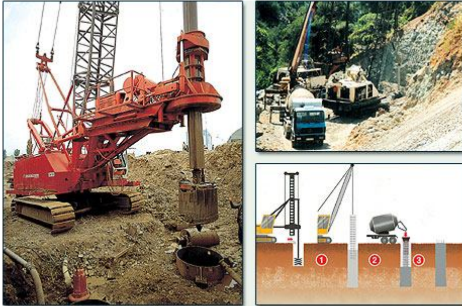
Şekil 4.3 Fore Kazık Yapım Aşamaları ( http://www.imoankara.org.tr/Portals/0/Sunum_cg_7.pdf )
