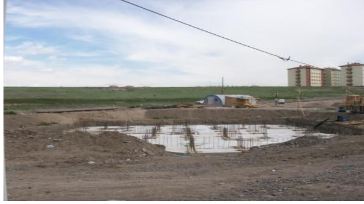
Şekil 3.6 Radye temelin betonlaşmış görüntüsü. ( http://www.gurmenltd.com/radye.htm )
