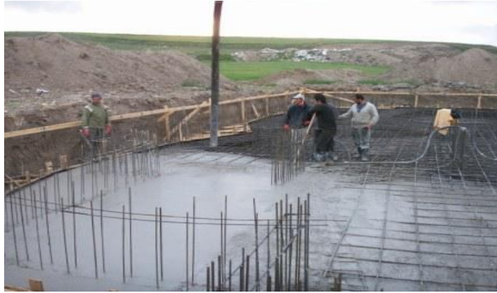
Şekil 3.5 Radye temelin beton atılırken görüntüsü. ( http://www.gurmenltd.com/radye.htm )
