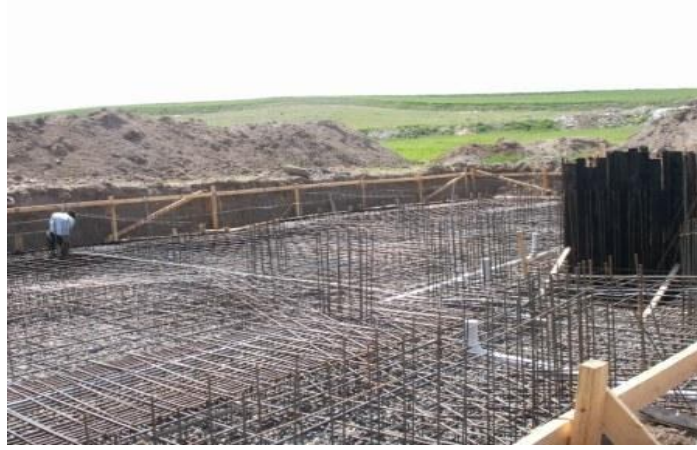
Şekil 3.4 Radye temelin beton dökülmeden önceki görüntüsü. ( http://www.gurmenltd.com/radye.htm )
