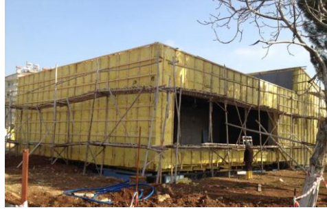
Resim 4.37: Dış cephe yalıtım uygulaması.
