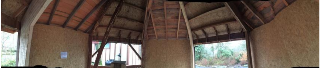
Resim 3.65: Ahşap taşıyıcı sistemi oluşturan farklı elemanların aynı yapıda kullanılması.
