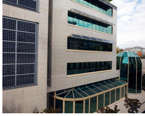
Resim 4.57:Cephede kullanılan güneş panelleri.
