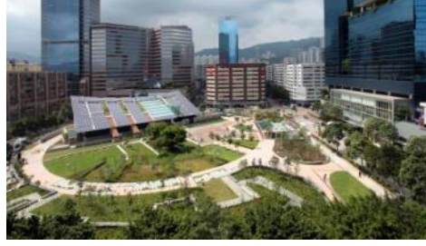
Resim 2.6:Yapı bulunduğu sıcak iklim koşullarına cevap vermek için, hakim rüzgarın yapı içerisine alınarak pasif havalandırma sağlayacak şekilde tasarlanmıştır.
