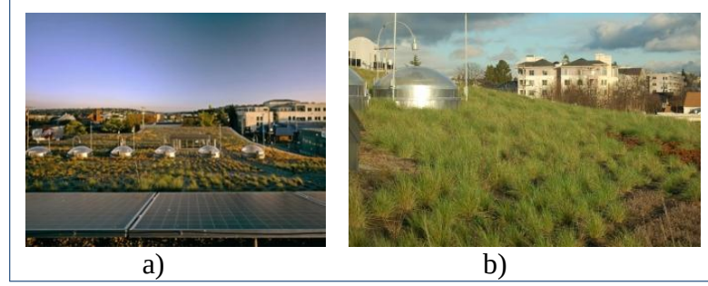
Resim 3.21: a) Çatıda bulunan fotovoltaik paneller ve çatı ışıklıkları, b) Yeşil çatı ve anemometreler.
