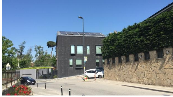
Resim 4.46: Çatıda bulunan güneş panelleri.
