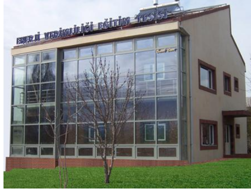
Resim 4.41: Enerji Verimliliği Eğitim Tesisleri Örnek Bina'nın genel görünüşü.
