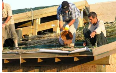
Resim 4.31: Farklı sonuçların gözlenmesi amacıyla çatı yalıtımında farklı malzemelerin kullanımı.
