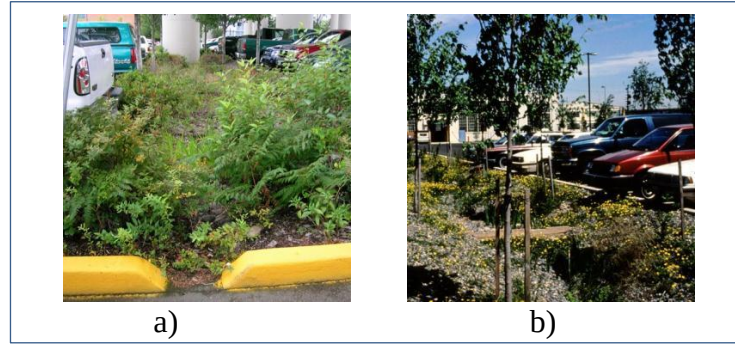
Resim 3.15: a) Yağmur suyu hendeklerinin düzenlenmesinde kullanılan bitki türleri, b) Otopark alanında yağmur suyu hendeklerinin düzenlemesi.
