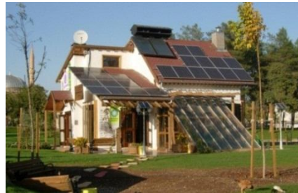
Resim 4.22: Güneş evi ön cephesi ve arka cephesi.
