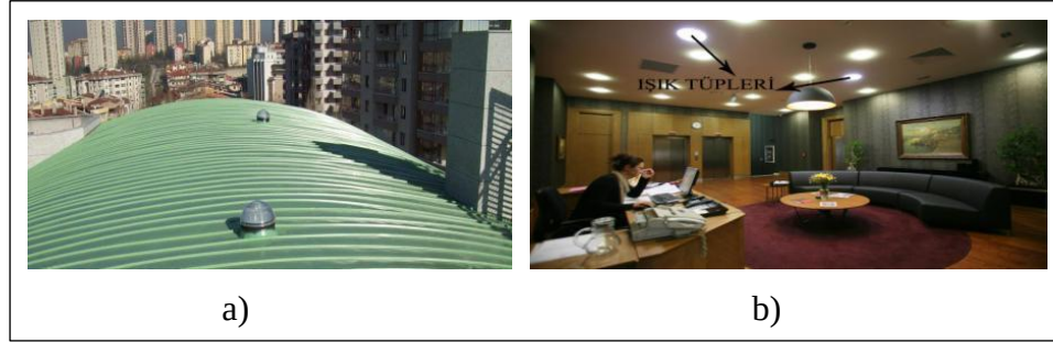
Resim 4.59: a) Işık tüplerinin çatıdan görünüşü, b) Işık tüplerini iç mekandan görünüşü.
