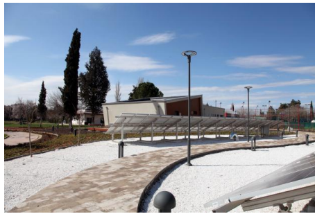
Resim 4.38: Kanada kuyusu hava girişleri ve güneş panelleri.
