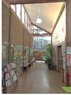
Resim 3.57: Bilgilendirme Merkezi'nde yer alan sıkıştırılmış toprak duvarlar ve çatı pencereleri.
