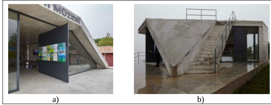
Resim 4.9: a) Ziyaretçileri yönlendirmeyi sağlayan pivot kapı, b) Terasa ulaşmayı sağlayan basamaklar.
