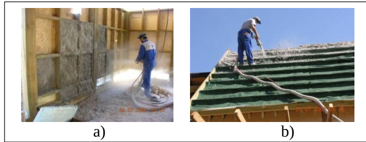
Resim 4.27: a) Selüloz ve bor bileşiği hamurundan üretilen yalıtım malzemesinin duvar uygulanması, b) Selüloz ve bor bileşiği hamurundan üretilen yalıtım malzemesinin çatı uygulanması.
