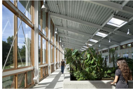
Resim 3.36: Yapı içerisinde bulunan ve arıtma işleminin gerçekleştirildiğı göletler.
