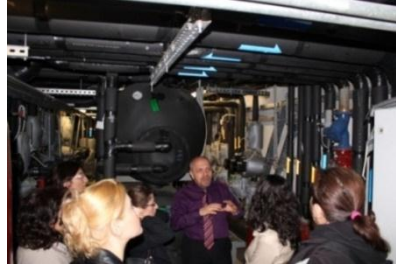
Resim 4.62: Yapının sahip olduđu sistemler yapı turu ile yerinde incelenmektedir.
