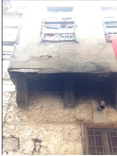
Şekil 2.2: Katı kirleticilerin neden olduğu cephe kusuru örneği.
