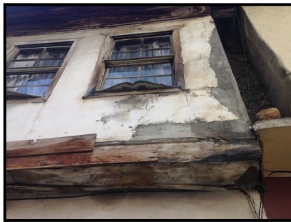
Şekil 2.4: Bakteri ve mantar etkisi.
