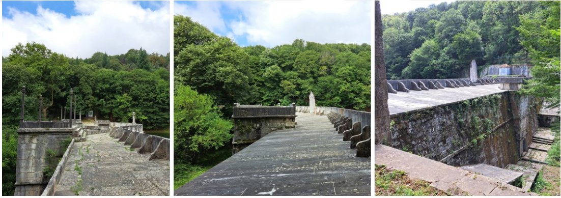
Şekil 5.15: Topuzlu, Valide ve Kirazlı bentlerinin korkuluksuz mansap yönleri.
