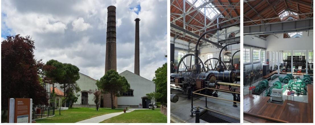
Şekil 4.7: Terkos Pompa İstasyonu [Balcan, 2024].
