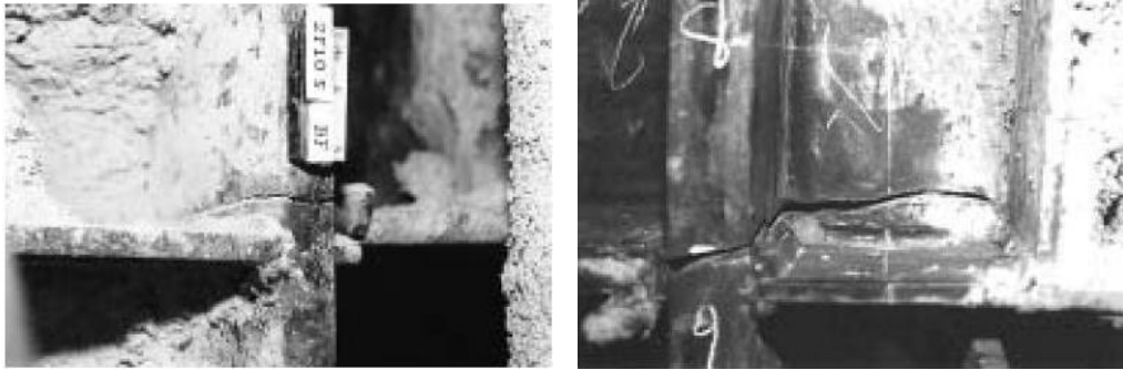
a. Kolon başlığında kırılma
