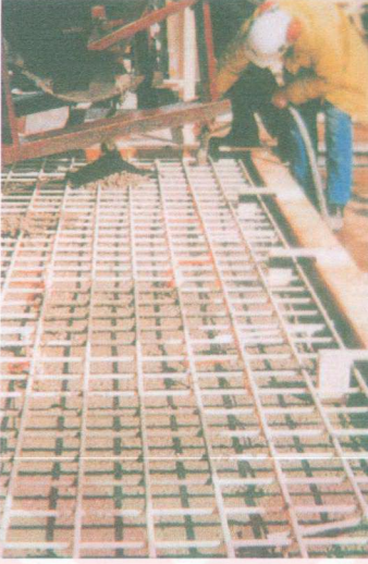
Şekil 2.5. CTP betonarme donatı uygulaması.
