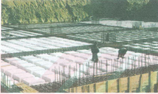
Şekil 2.2. Kaset döşeme kalıp uygulaması.
