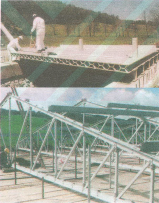
Şekil 2.3. CTP köprü tabliyesi ve çatı makası uygulamaları.
