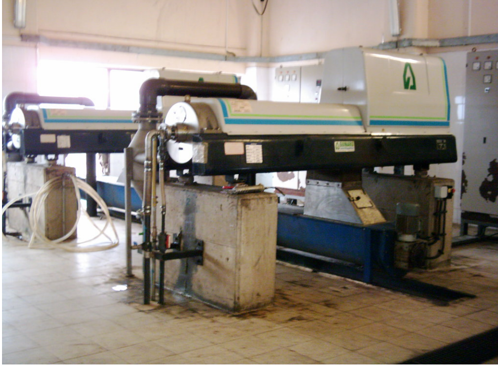
Şekil 3.10. Çamur Susuzlaştırma Binası.
