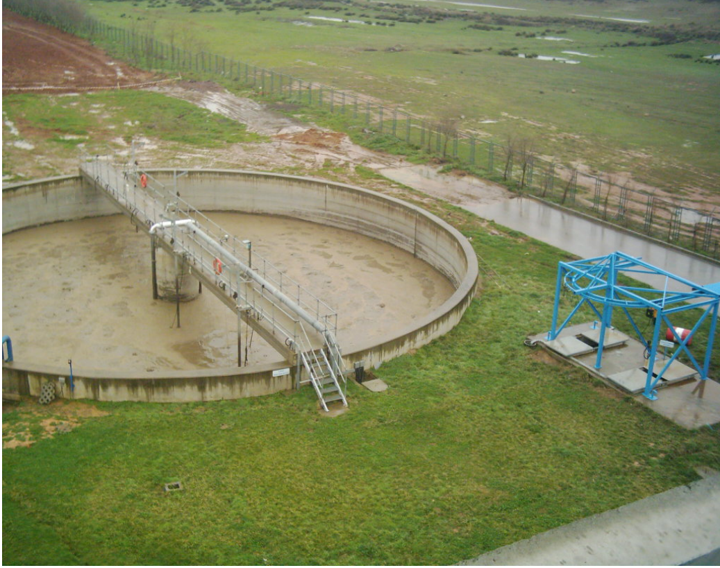
Şekil 3.9.Çamur Depolama Havuzu.
