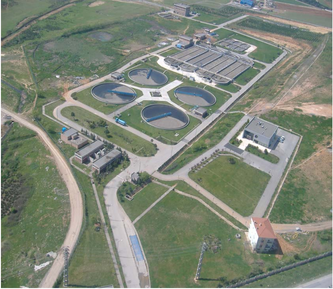
Şekil 3.4. Paşaköy Atıksu Arıtma Tesisi Kuşbakışı Görünümü.
