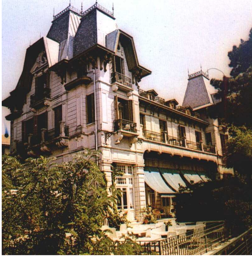
Ft. 3. 52. Anadolu Kulübü Büyükada Şube yapısı ön görünüş (Tuğlacı, 1995)
