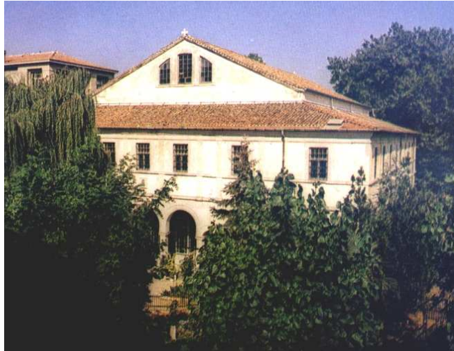
Ft. 3. 33. Aya Dimitri Kilisesi ön cephesi (Tuğlacı, 1995)
