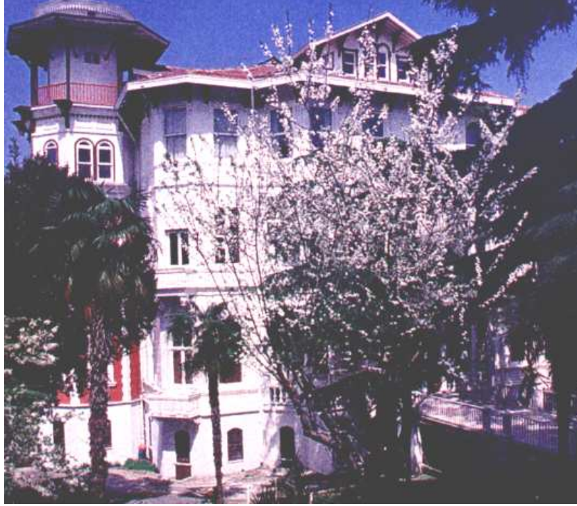
Ft. 3. 44. Kaymakamlık (Hacopulo) Köşkü ön cephesi
