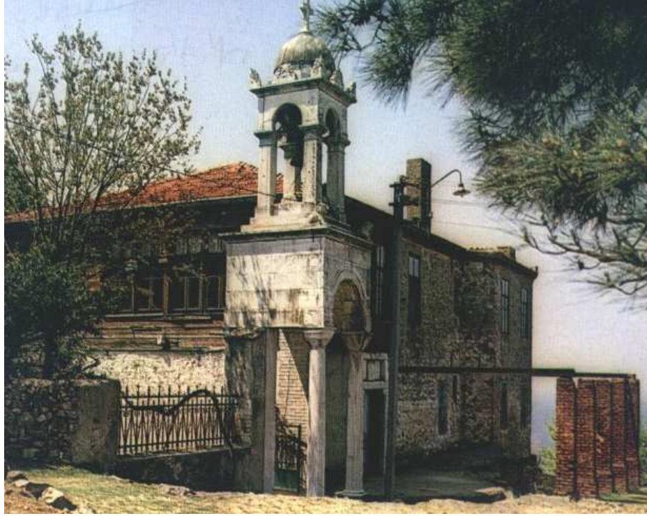
Ft. 3. 15. Aya Yorgi Kilisesi yan görünüş ve çan kulesi (Tuğlacı, 1995)
