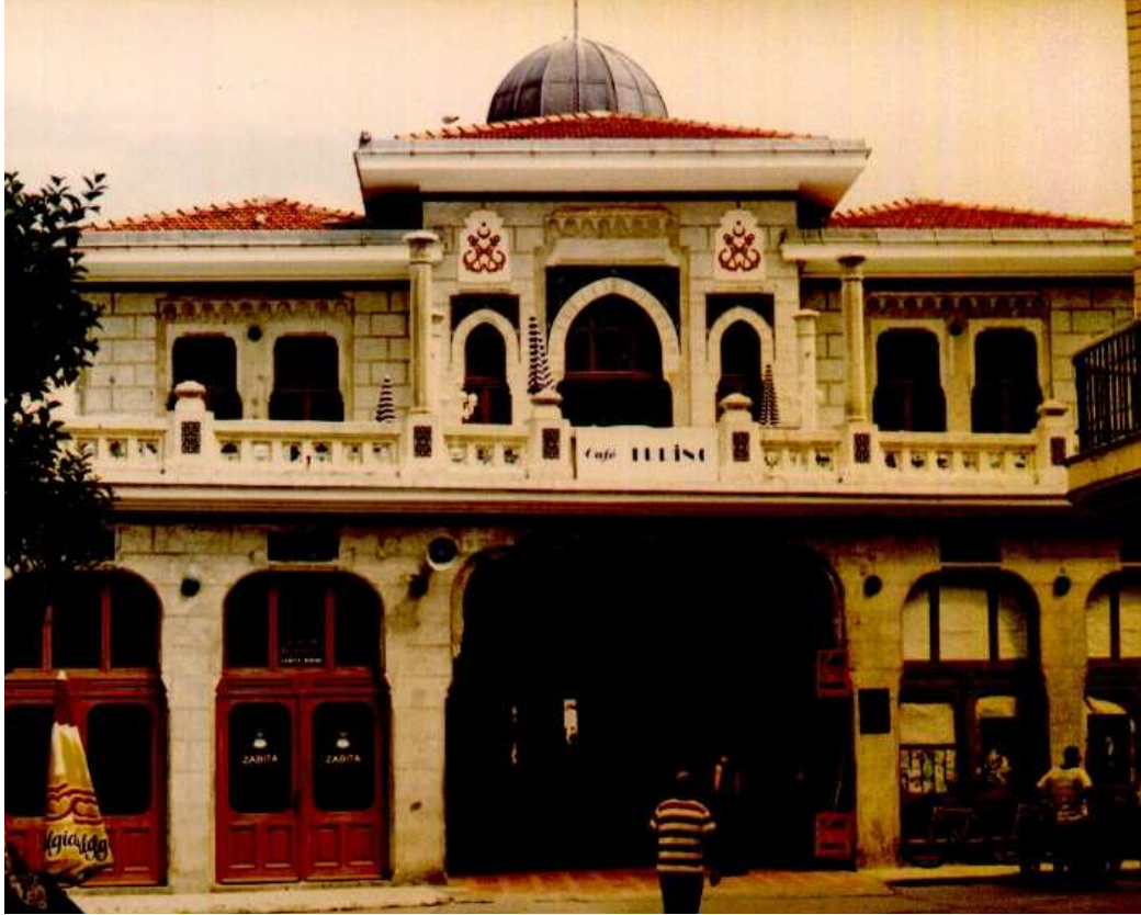
Ft. 3. 75. Vapur iskele binası yol cephesinden görünüş
