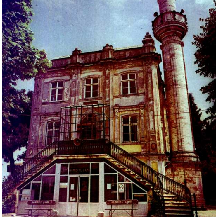
Ft. 3. 47. Hamidiye camii ön görünüşü (Tuğlacı, 1995)
