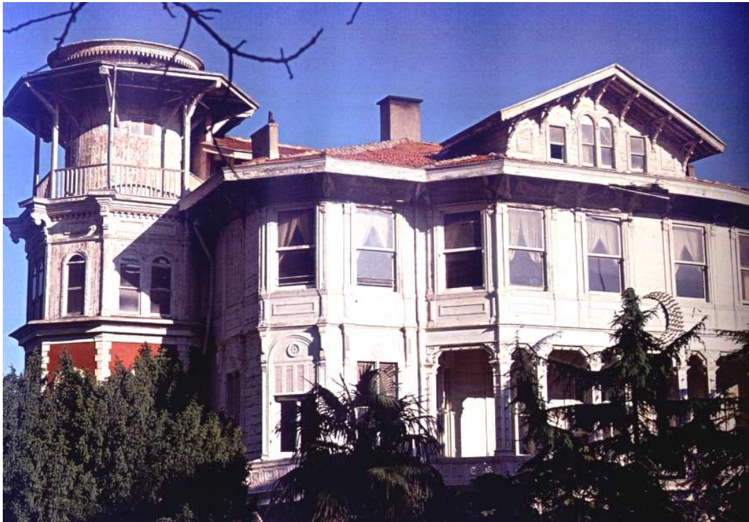
Ft. 3. 46. Kaymakamlık Köşkü kule ve çatı katı ön görünüş (Milas, 2000b)
