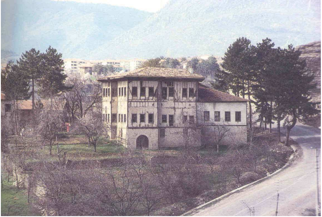
Resim 3.2. Safranbolu, Asmazlar Konağı restorasyon Öncesi (61)
