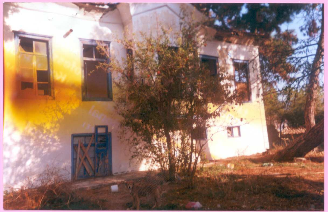
Resim 6.2., Akdoğan Evinden Yan (Kuzey) Cephesi
