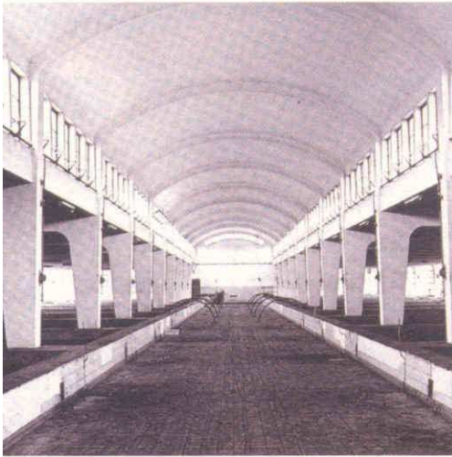
Resim 3.25. Arıtma Tesisi (Restorasyondan Önce), Rotterdam-Hollanda (61)
