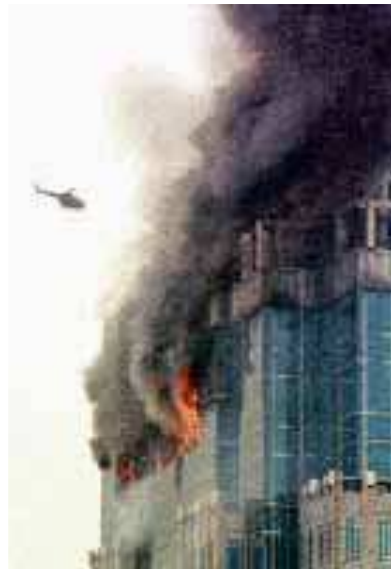
Şekil 1.5. 8 Aralık 1997-Endonezya’nın başkenti Jakarta’da 25 katlı Merkez Bankası kompleksinin kulesinde çıkan yangın, [Hürriyet, 1997].
