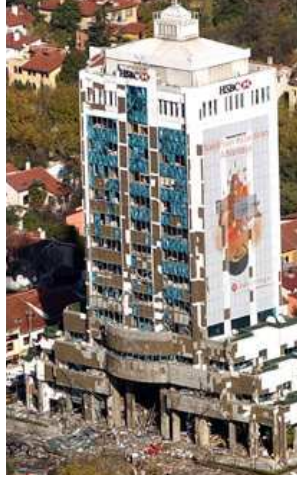
Şekil 1.9. 20 Kasım 2003 terörist saldırı sonrası İstanbul HSBC Genel Müdürlük Binası, [NTV, 2003].
