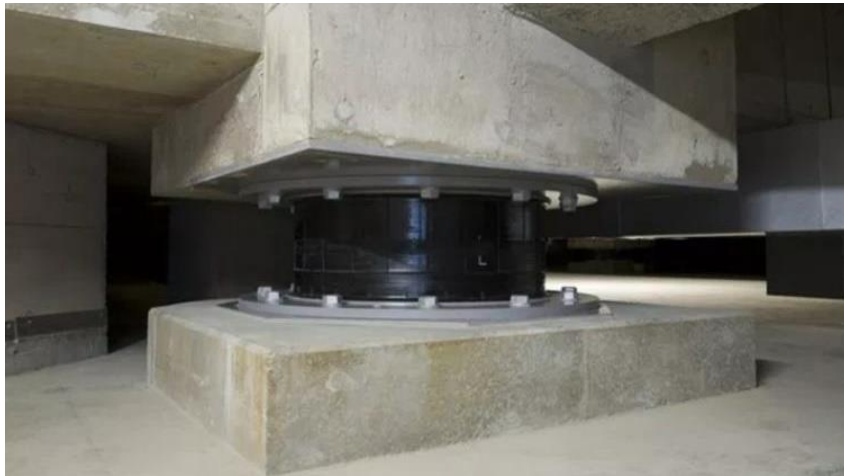
Şekil 2.3: Kauçuk izolatör (HDRB).
