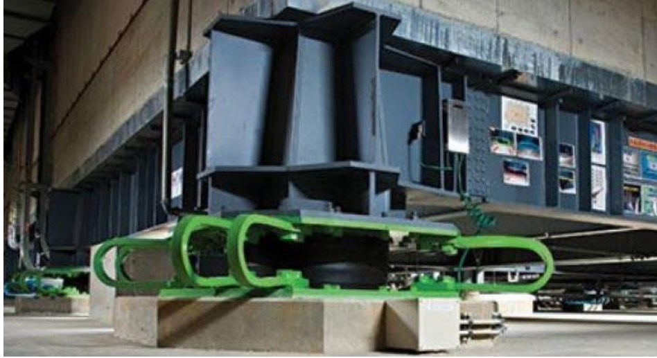
Şekil 2.12: İzolatörle kullanılan “U” şekilli damper örneği.
