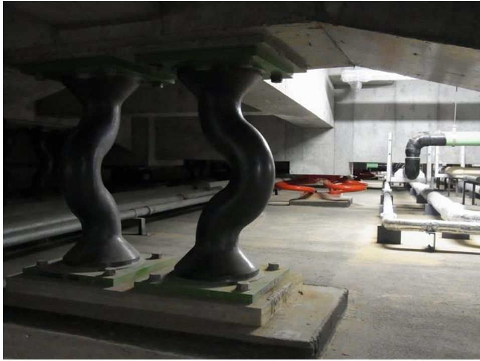
Şekil 2.13: İzolatörle kullanılan kurşun ve helisel şekilli damper örneği.
