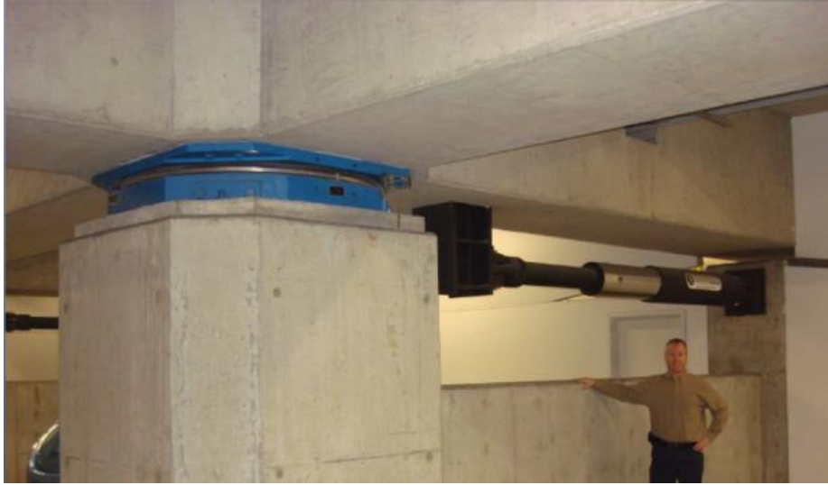
Şekil 2.11: İzolatörle birlikte kullanılan viskoz damper örneği.
