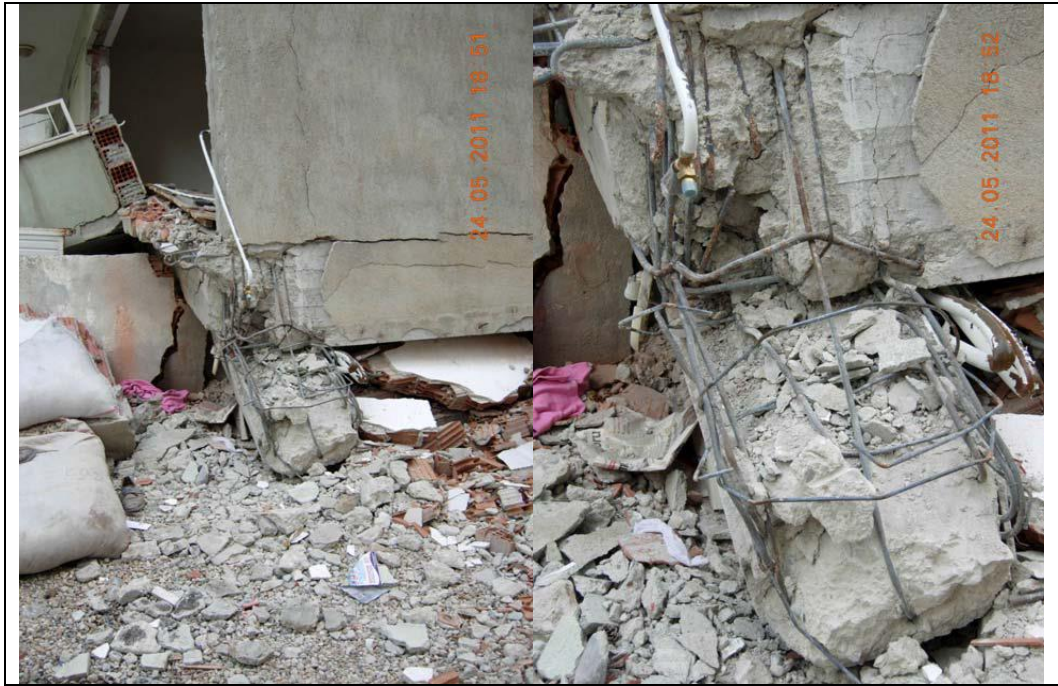
Şekil 4.14: a) Yıkılan binanın kuzeybatı köşe kolonu, b) Yıkılan binanın zemin kat kuzeybatı köşe kolon–kiriş birleşim bölgesindeki hasar.
