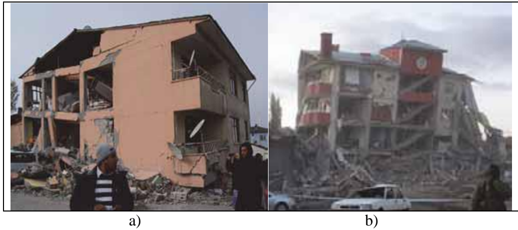
Şekil 4.6: a) ) 23 Ekim 2011 Van Depremi, yumuşak kat düzensizliği nedeniyle yıkılmış 3 katlı bina, b) Yumuşak kat düzensizliği nedeniyle yıkılmış 5 katlı bina.
