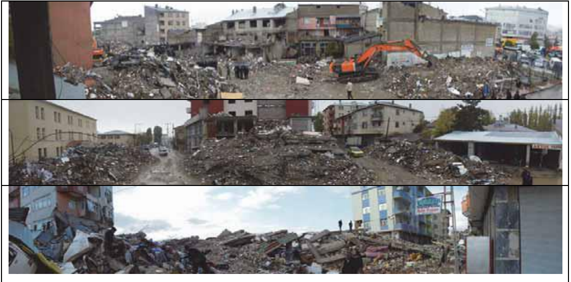
Şekil 4.4: 23 Ekim 2011 Van Depremi, tamamen göçmüş bina örnekleri.
