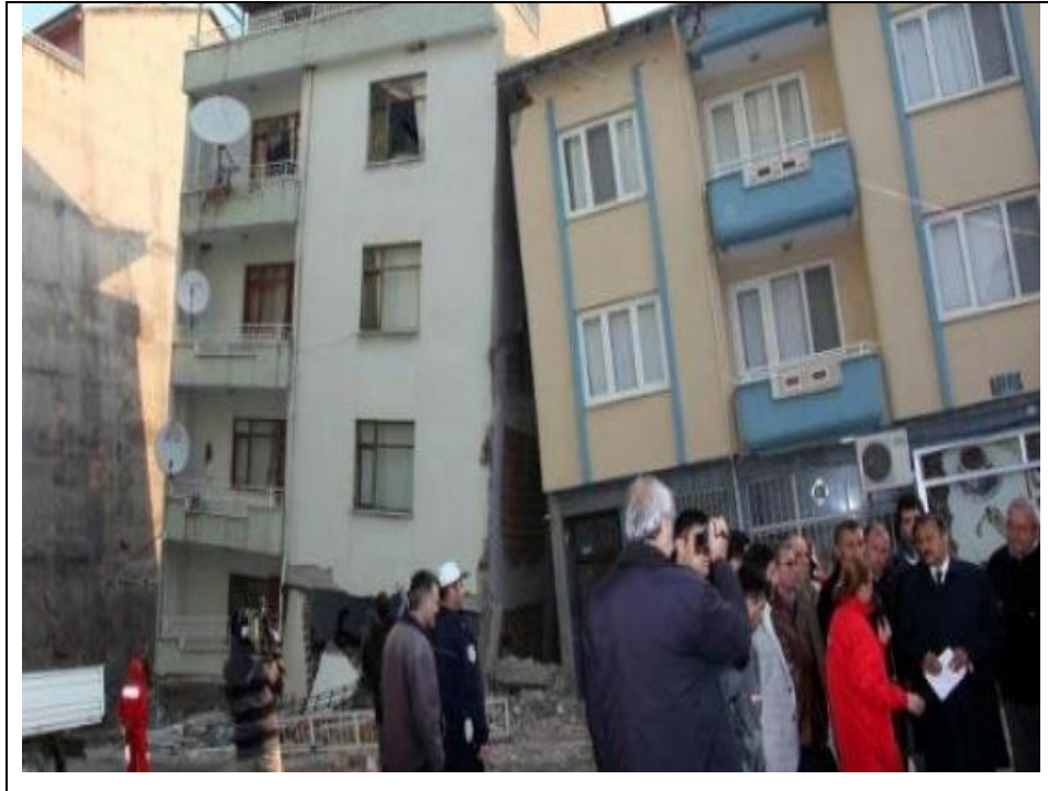
Şekil 4.12: Depremden sonra yıkılmış bitişik nizam bir bina örneği.
