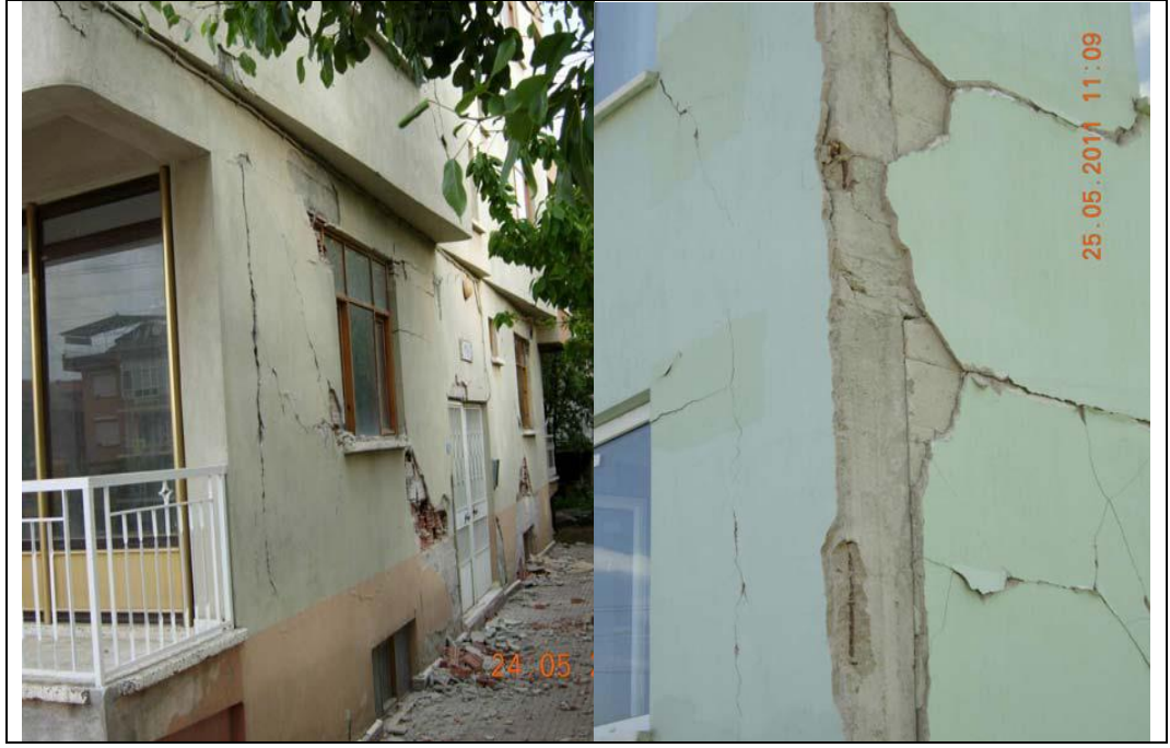
Şekil 4.15: a) 3 katlı binada meydana gelmiş dolgu duvar hasarı örneği, b) 7 katlı binada meydana gelmiş dolgu duvar hasarı örneği.
