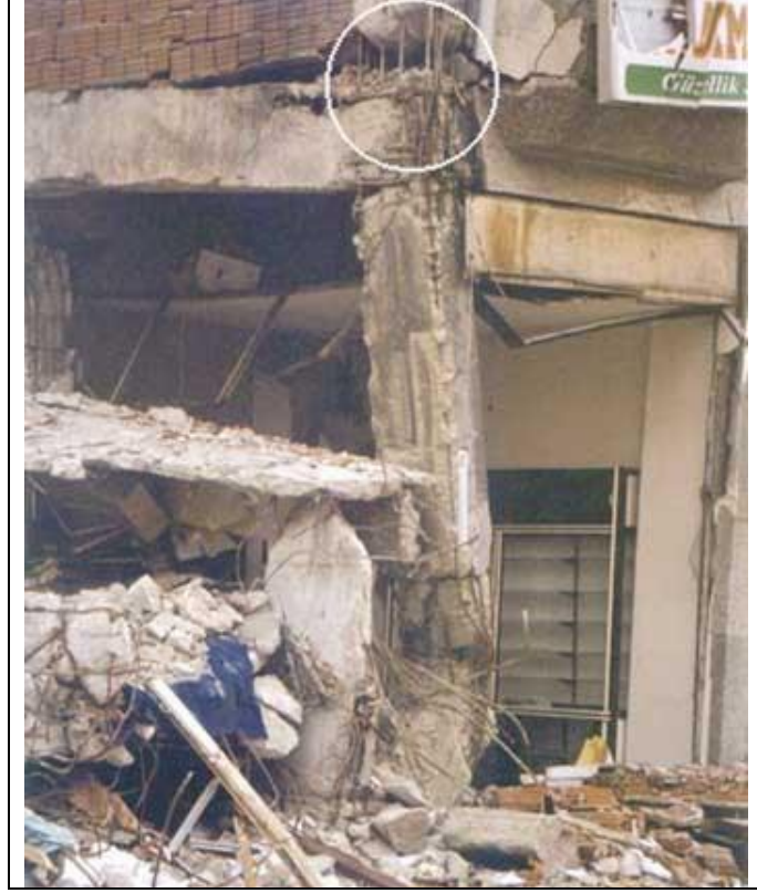
Şekil 3.9: Standartlara uygun olmayan malzeme kullanımı ve işçilik kusurları nedeni ile meydana gelmiş hasar örneği.
