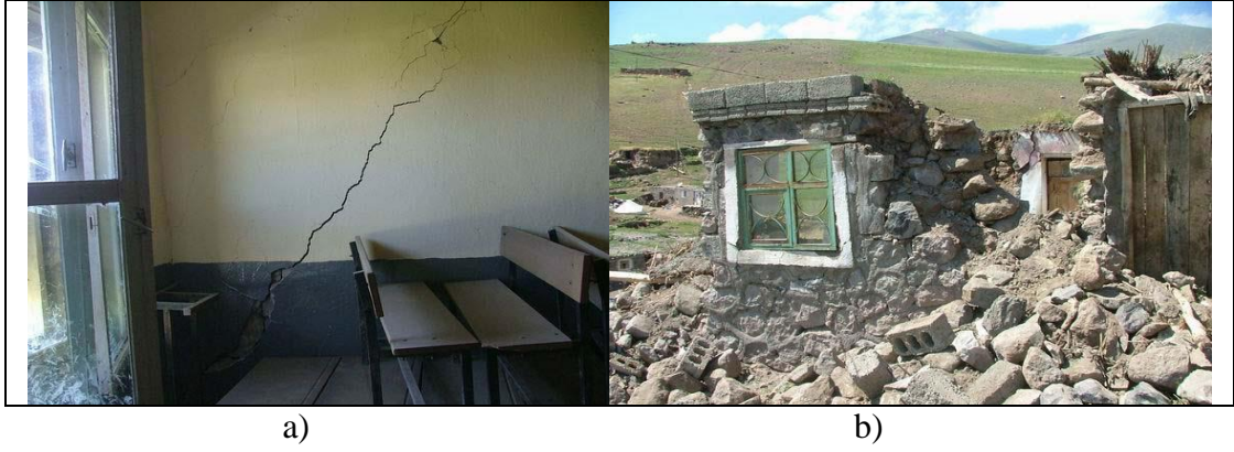
Şekil 3.14: a) Köşe duvarlarda oluşmuş kesme çatlakları, b) Duvar köşelerinden hasar alarak yıkılmış yapı örneği görülmektedir.
