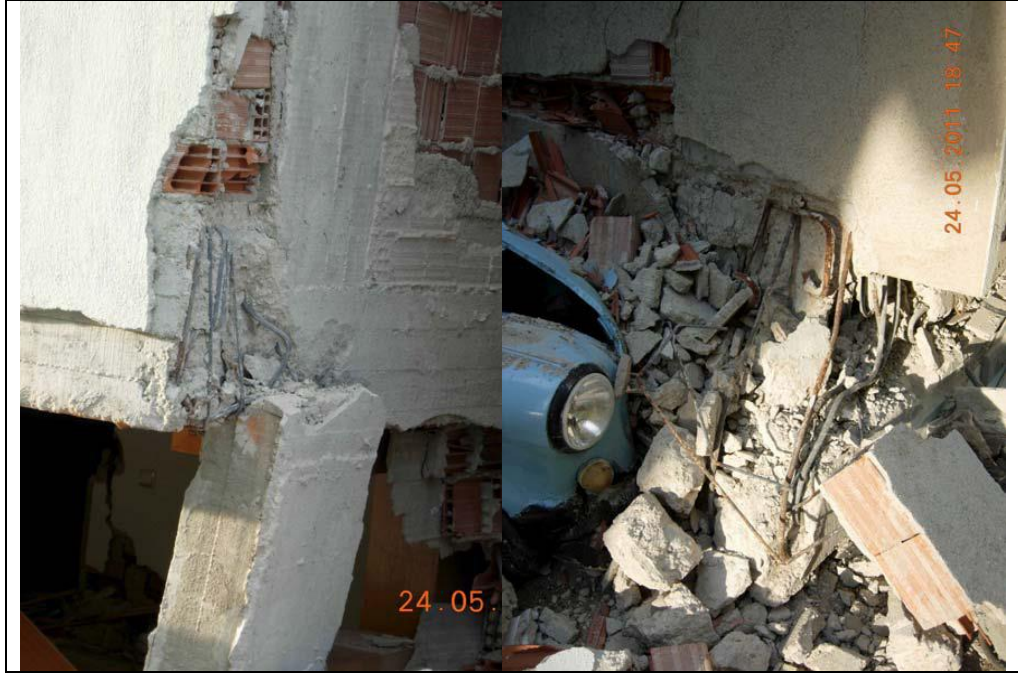
Şekil 4.13: a) Yıkılan binanın güneydoğu yönündeki köşe kolonundaki hasar, b) Yıkılan binanın zemin kat güneybatı yönündeki köşe kolonlarındaki hasar.
