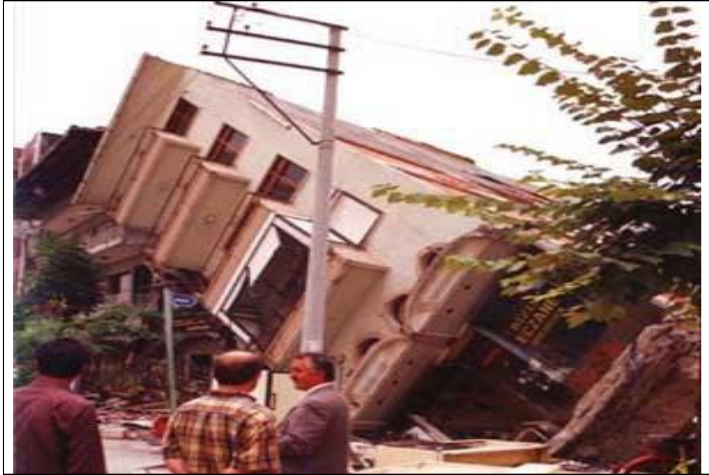
Şekil 3.4: Çekiçleme etkisiyle devrilmeye maruz kalmış yapı örneği.
