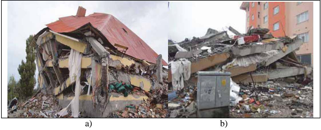
Şekil 4.5: a) 23 Ekim 2011 Van Depremi, katların üst üste yığılması sonucu yıkılmış 3 katlı bina, b) Katların üst üste yığılması sonucu yıkılmış 4 katlı bina
