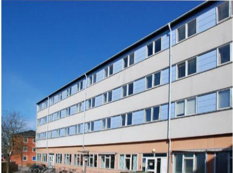
Şekil 5. 20: Konutun iyileştirmeden önceki görünüşü.
