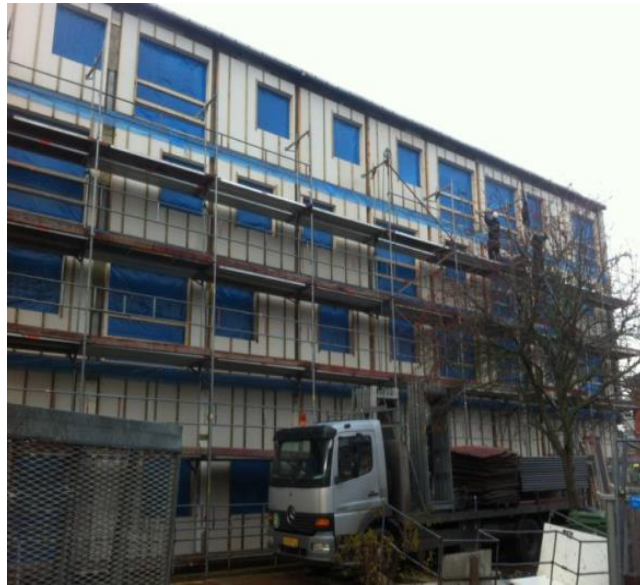
Şekil 5. 22: İyileştirme aşamasında cephenin görünümü.
