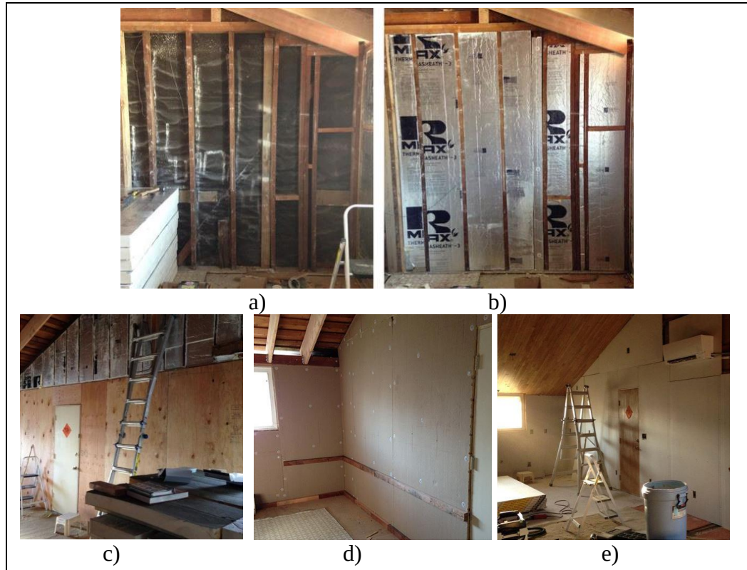
Şekil 5. 50: a)Yalıtımsız dış duvar, b) Çerçeve aralarına yalıtım uygulanması, c) Yalıtım üzerine kontraplak monte edilmesi, d) Kontraplak üzerine ikinci kat yalıtımın uygulanması, e) Alçıpan monte edilmesi.
