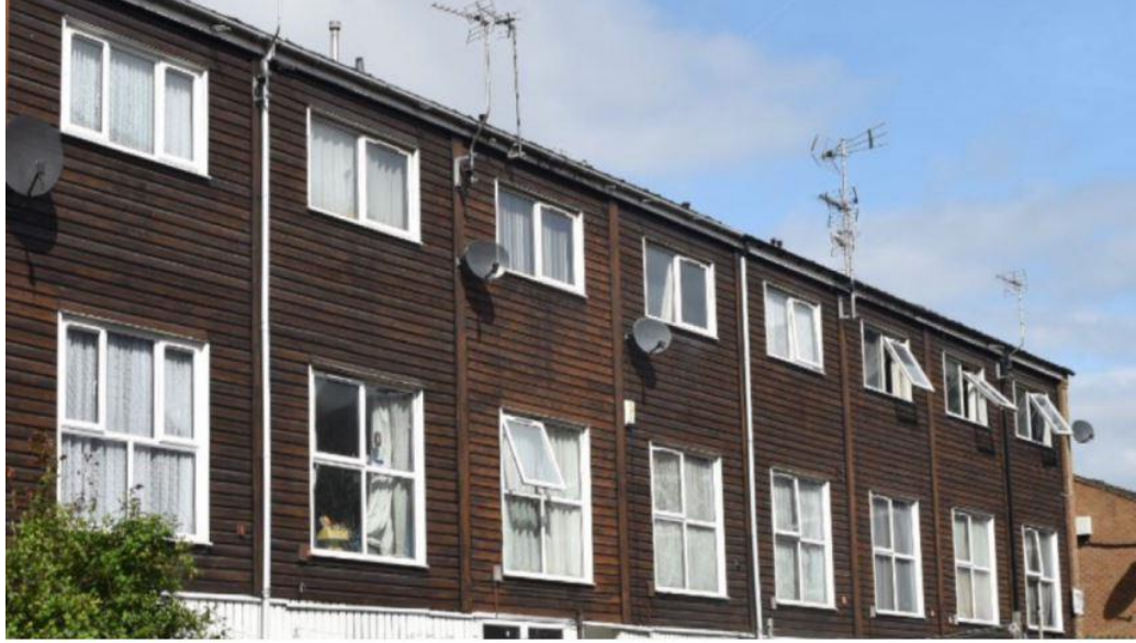
Şekil 5. 34: Konutun iyileştirmeden önceki görünüşü.
