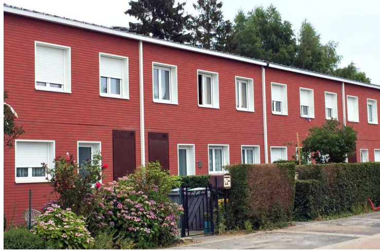
Şekil 5. 31: Konutun iyileştirmeden sonraki görünüşü.
