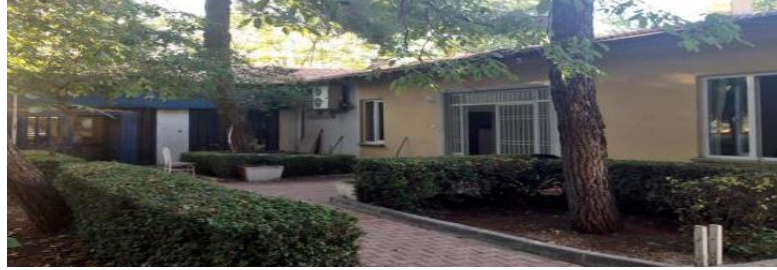
Şekil 5.53: Yapının iyileştirmeden önceki görünüşü.
