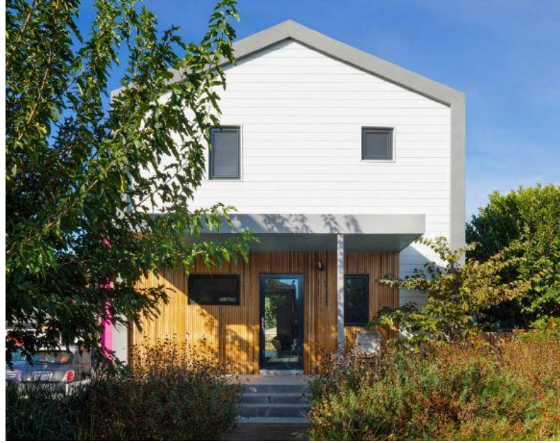
Şekil 5. 40: Konutun iyileştirmeden önceki görünüşü.
