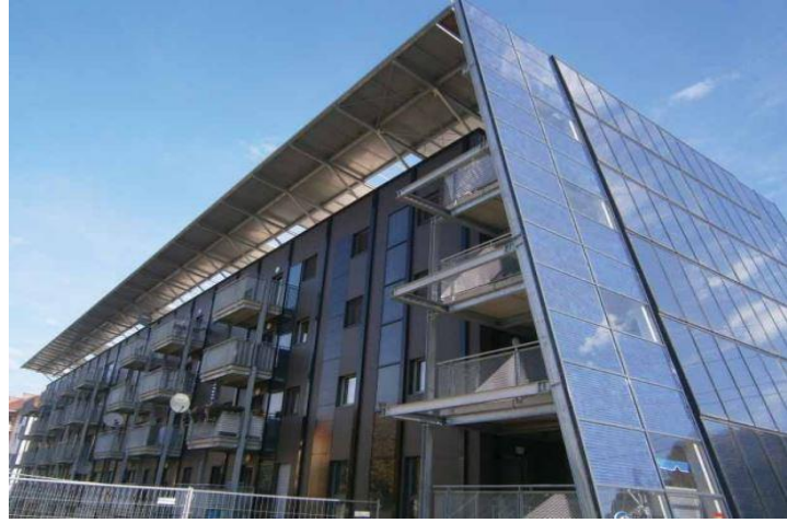
Şekil 5. 9: Konutun iyileştirmeden sonraki görünüşü.
