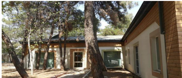
Şekil 5.55: Yapının iyileştirmeden sonraki görünüşü.
