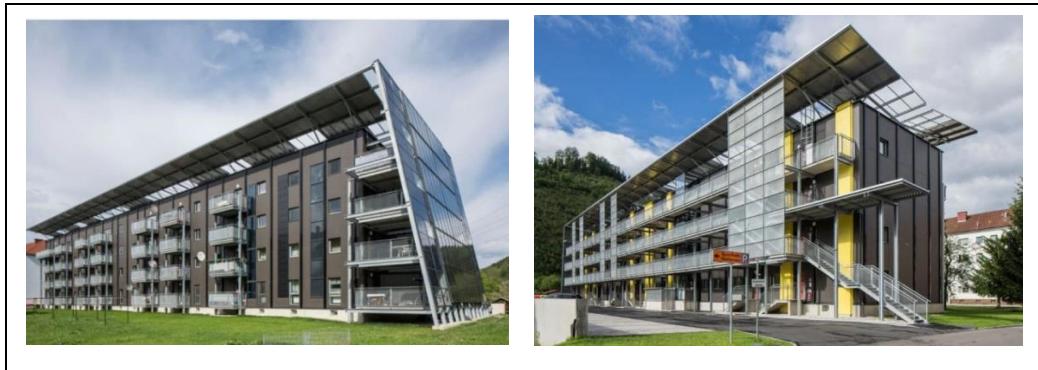
Şekil 5. 15: İyileştirme sonrası konutun farklı cephelerinin görünümü.
