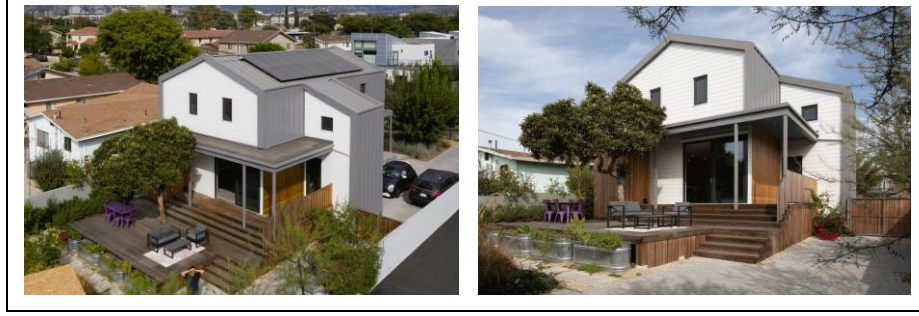
Şekil 5. 47: İyileştirme sonrası konutun farklı cephelerinin görünümü.
