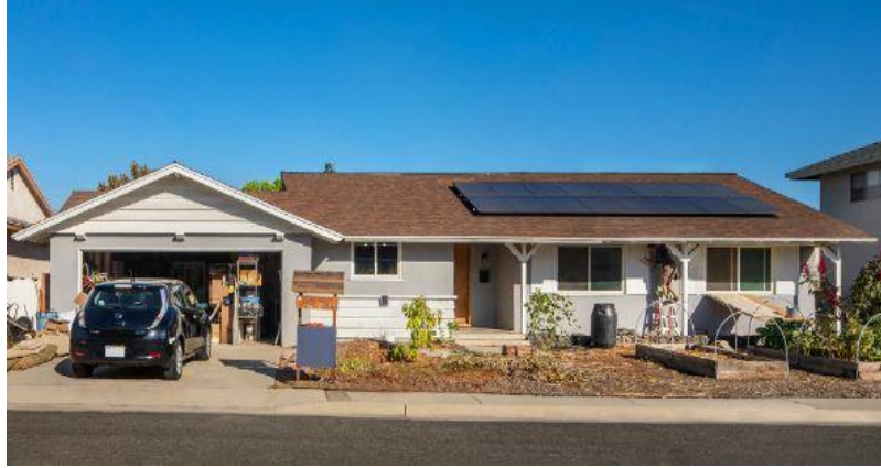
Şekil 5. 49: Konutun iyileştirmeden sonraki görünüşü.
