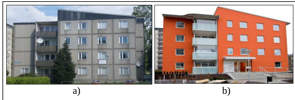
Şekil 4. 14: Ekleme-dış stratejisi, a) İyileştirme öncesi, b) İyileştirme sonrası.
