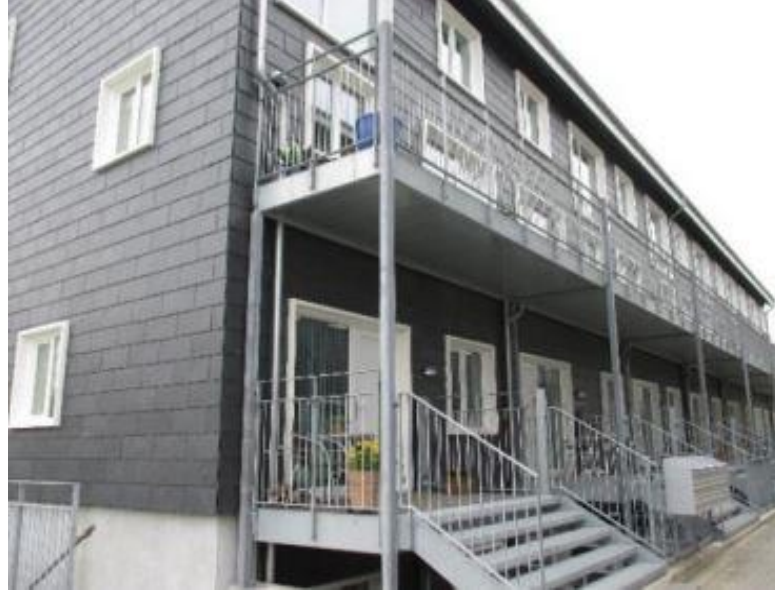
Şekil 5. 23: Eklenen yeni çelik balkonlar.
