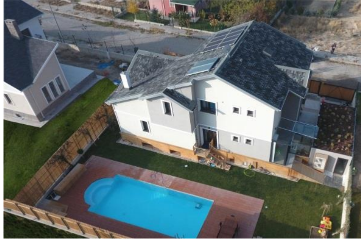
Şekil 5. 59: Konutun iyileştirmeden sonraki görünüşü.
