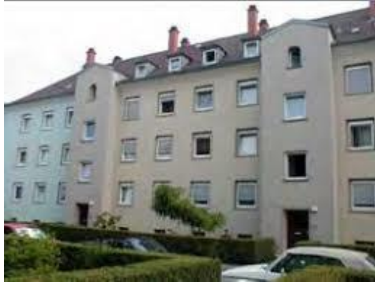
Şekil 5. 16: Konutun iyileştirmeden önceki görünüşü
