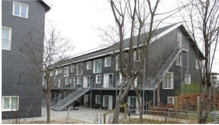
Şekil 5. 21: Konutun iyileştirmeden sonraki görünüşü.
