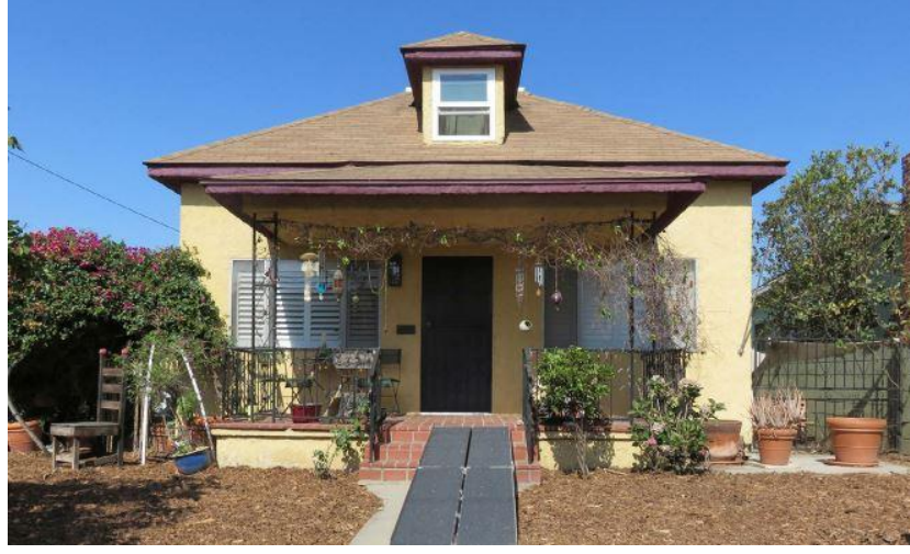
Şekil 5. 39: Konutun iyileştirmeden önceki görünüşü.
