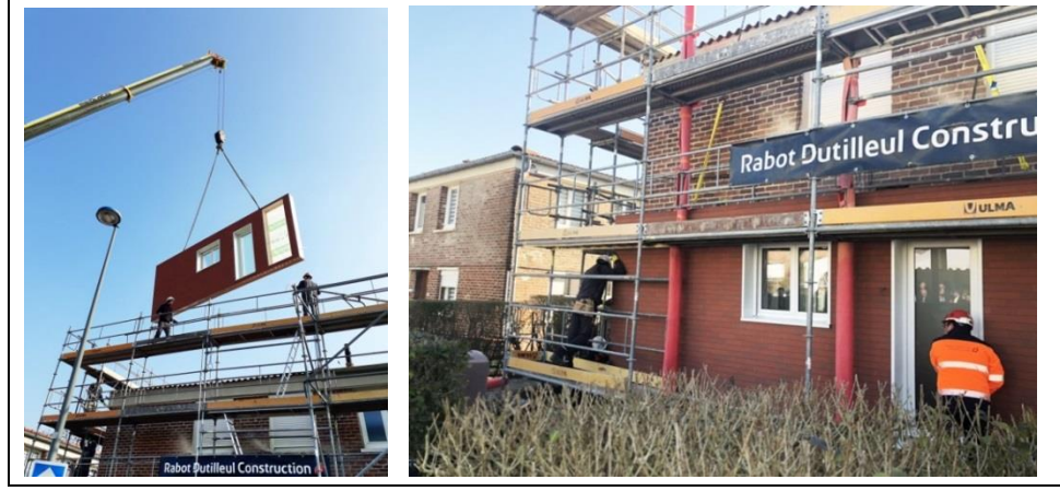
Şekil 5. 32: Ön yapımlı panellerin sahada montaj aşaması.
