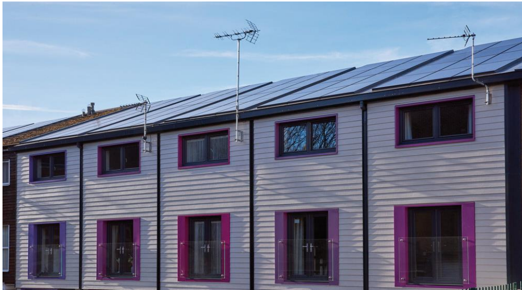
Şekil 5. 35: Konutun iyileştirmeden sonraki görünüşü.
