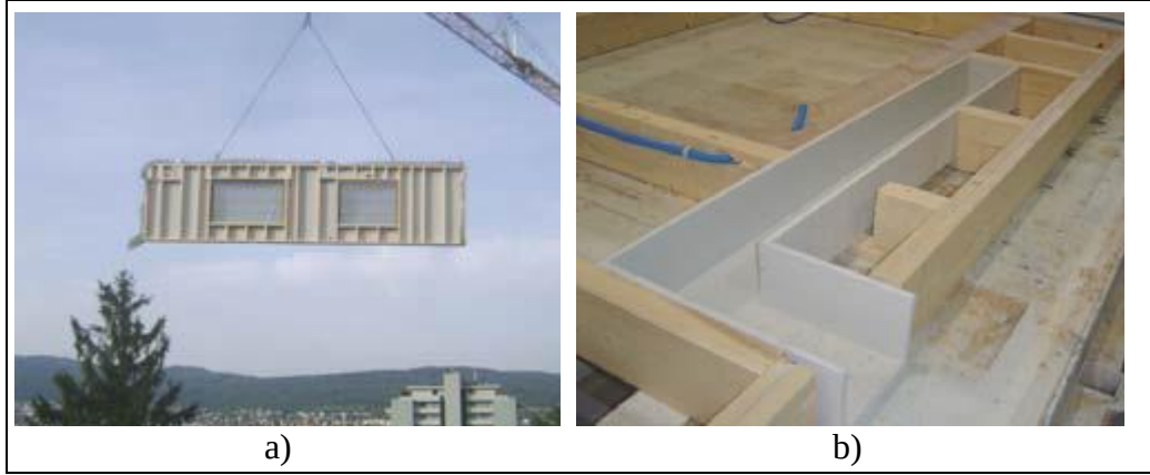
Şekil 5. 3: a) 3 x 10 m cephe elemanının sahaya taşınması, b) Havalandırma boşluklu cephe elemanının fabrikada üretimi.
