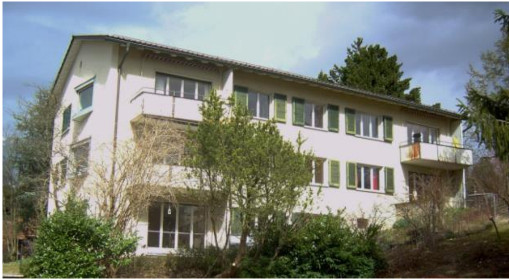
Şekil 5. 1: Konutun iyileştirmeden önceki görünüşü.
