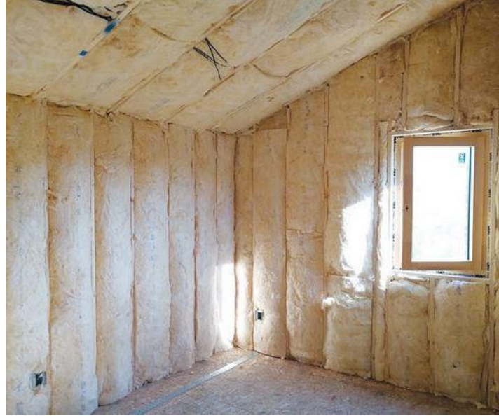
Şekil 5. 43: İkinci duvarın cam yünü yalıtım katmanı.
