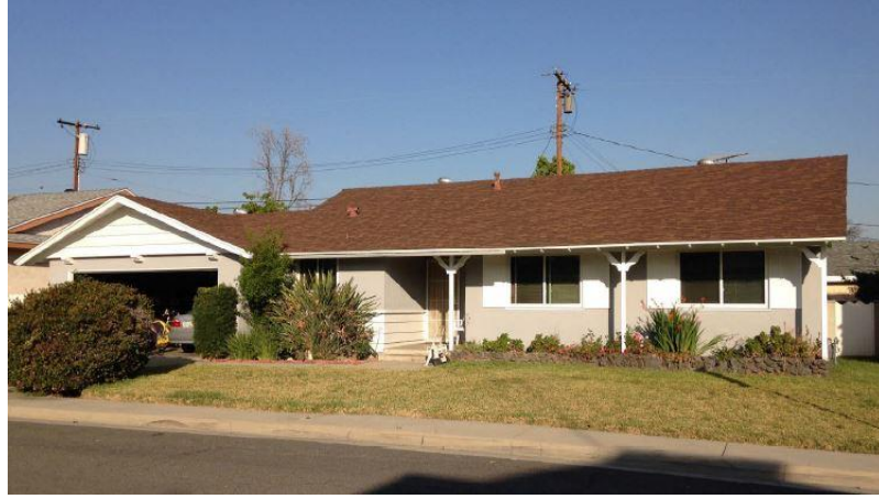
Şekil 5. 48: Konutun iyileştirmeden önceki görünüşü.
