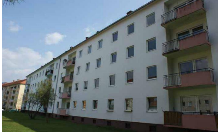
Şekil 5. 8: Konutun iyileştirmeden önceki görünüşü.
