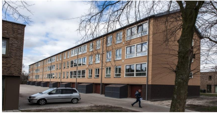
Şekil 5. 26: Konutun iyileştirmeden sonraki görünüşü.
