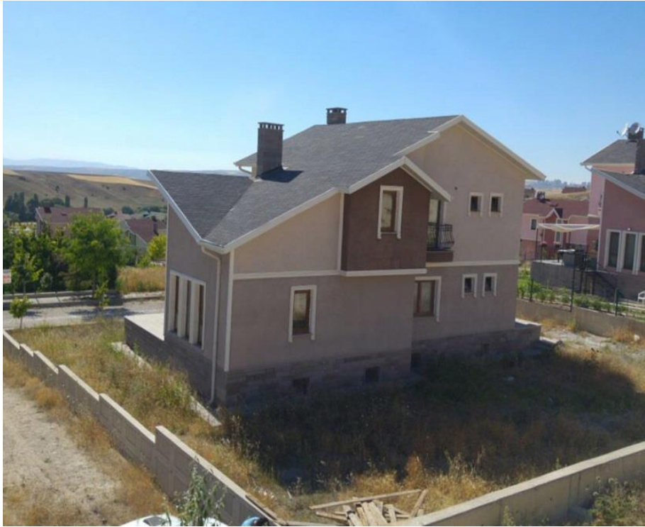
Şekil 5. 58: Konutun iyileştirmeden önceki görünüşü.
