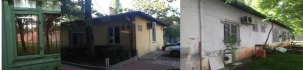
Şekil 5.54: İyileştirme öncesi yapının farklı cephelerinin görünümü.
