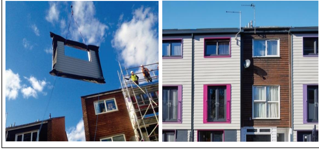
Şekil 5. 36: Ön yapımı panellerin sahada montaj aşaması.
