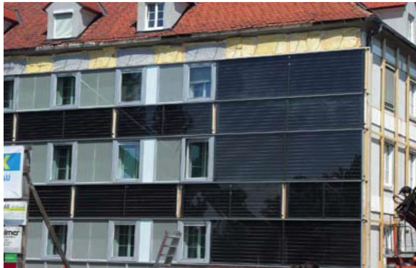
Şekil 4. 28: Güneş kolektörleri eklenmiş yatay ön yapımlı modüller.
