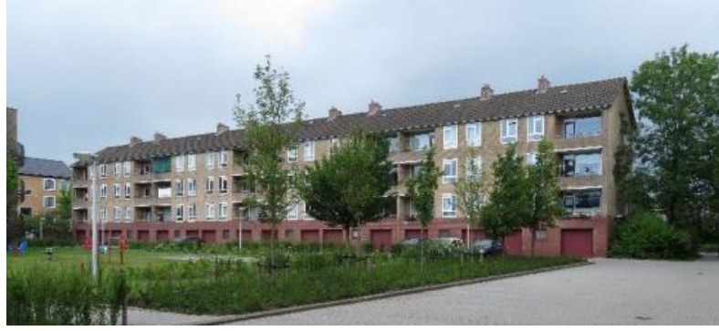
Şekil 5. 25: Konutun iyileştirmeden önceki görünüşü.
