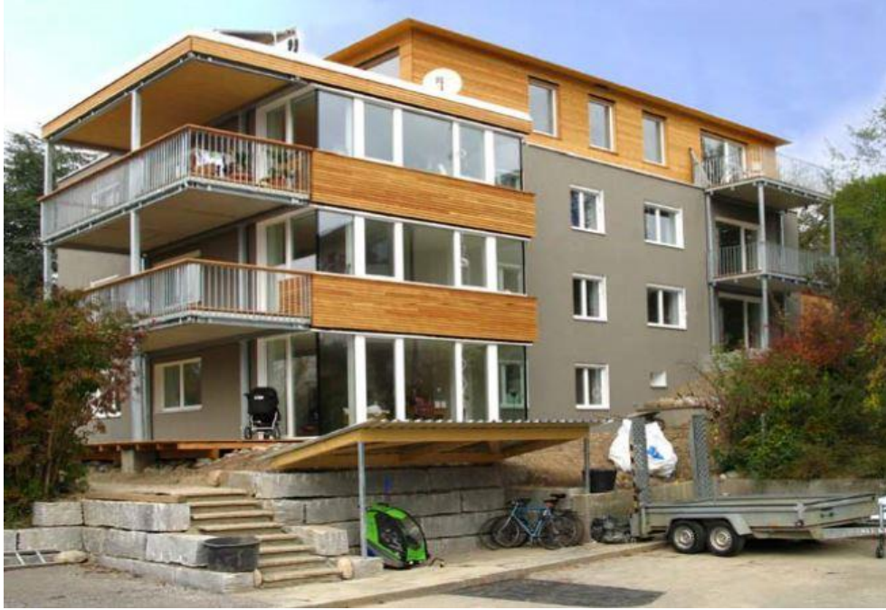
Şekil 5. 2: Konutun iyileştirmeden sonraki görünüşü.
