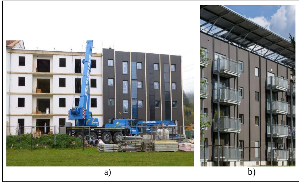
Şekil 5. 11: a) Ön yapımlı cephe modüllerinin batı cepheye montajı, b) Eklenen yeni balkonlar.
