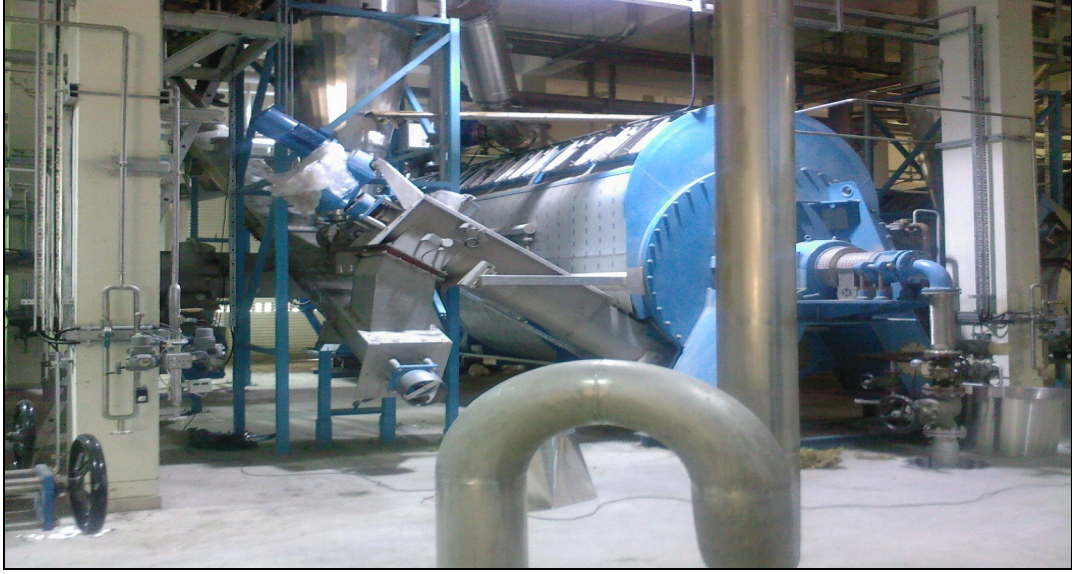
Şekil.4.10. Çamur kurutucu-Ataköy
