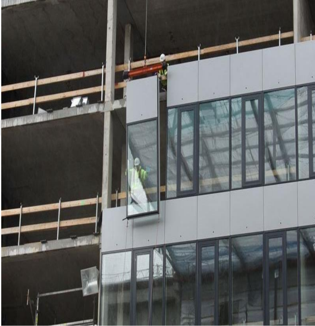
Şekil 2.6: Panel Cephe Montajı [Web 9, 2023].
