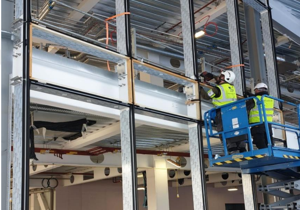
Şekil 2.3: Çubuk Cephe Sistemi Montajı [Web 6, 2023].
