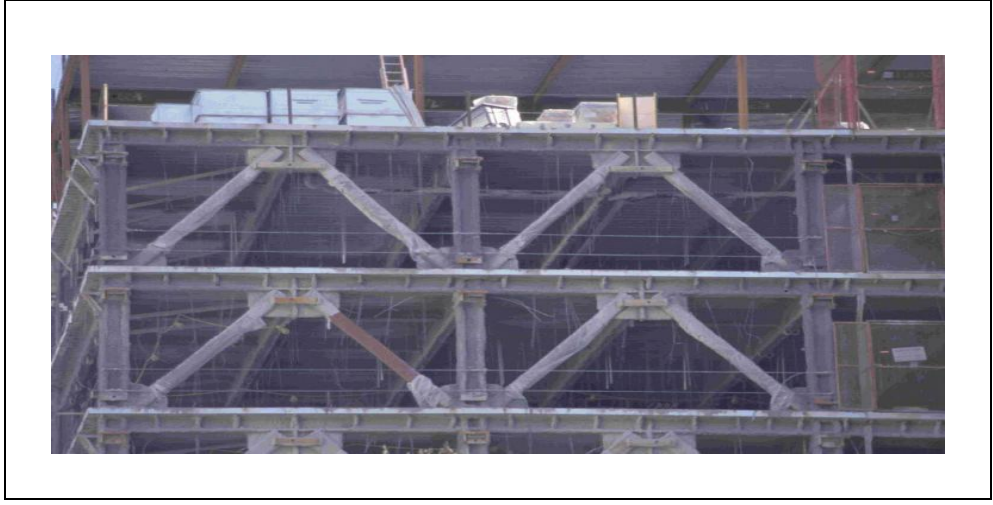
Şekil 2.2: Merkezi çaprazlı çerçeve.
