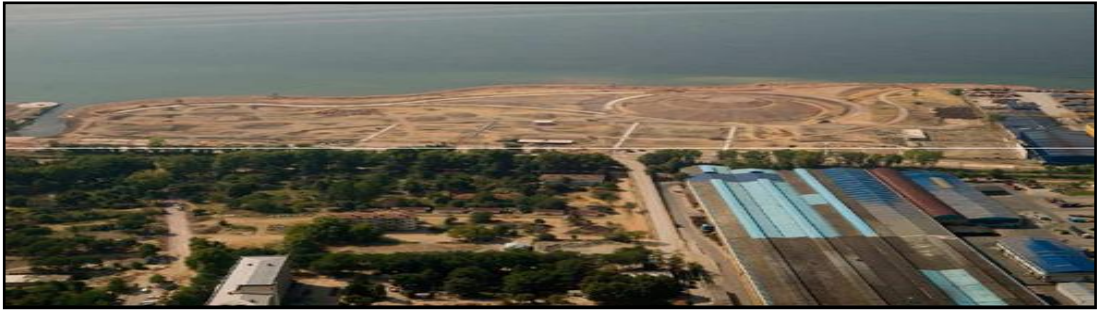
Şekil 3.12: İnşaat aşamasında Sekapark.
