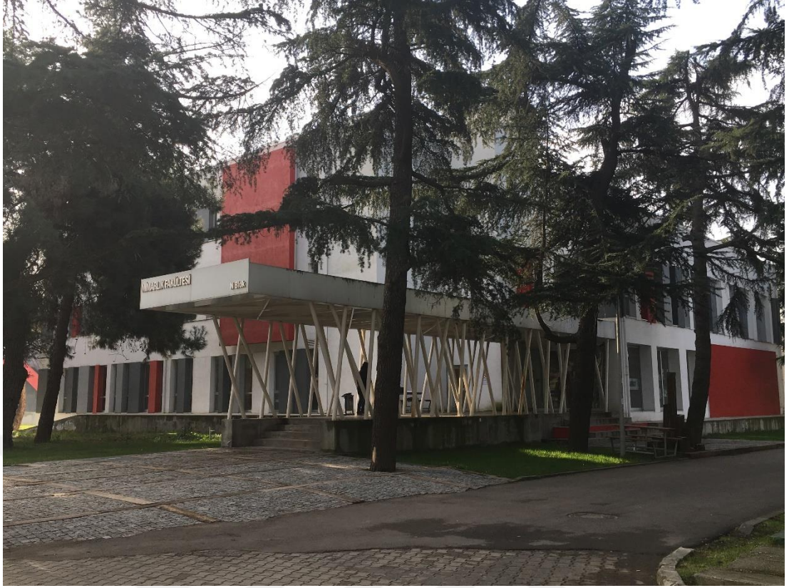
Şekil 4.2: Contam Simülasyon Aracı ile Simüle Edilen GTÜ Mimarlık Bölümü N Blok Binası [WEB 13, GTÜ, 2025].
