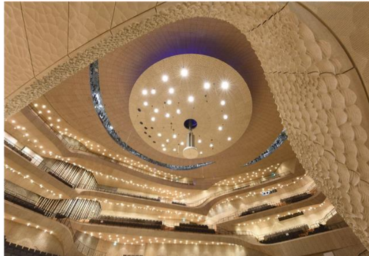
Şekil 4.3: Elbphilharmonie akustik paneller [Web 6].
