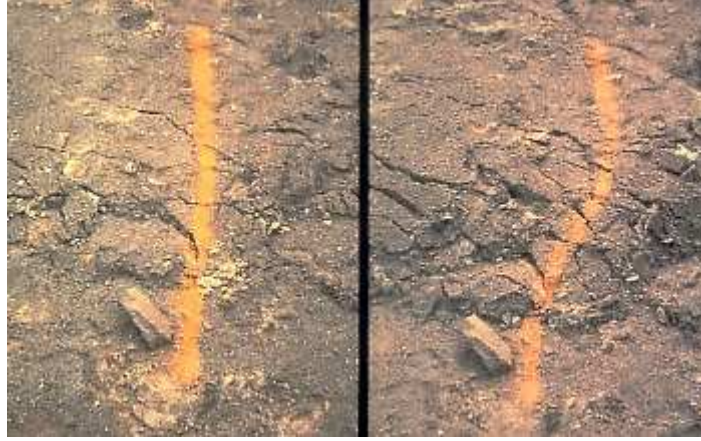
Şekil 2.1.: Jeolojik sebeplerden dolayı bir deformasyon örneği,[HGK (www.hgk.mil.tr)]
