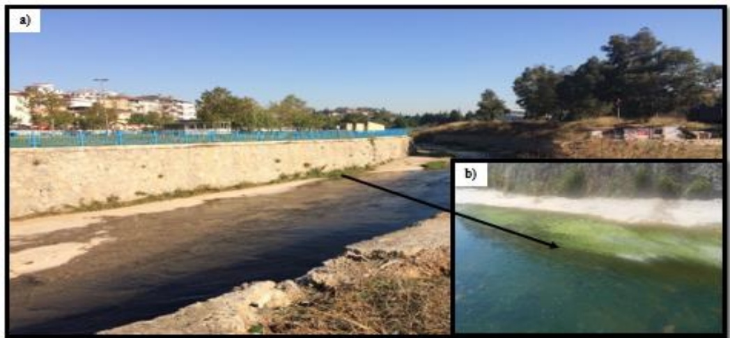
Şekil 4.10: Saz Deresi içinde yeraltı suyuna süzülmeleri önlemek için geçirimsiz taban uygulamaları.
