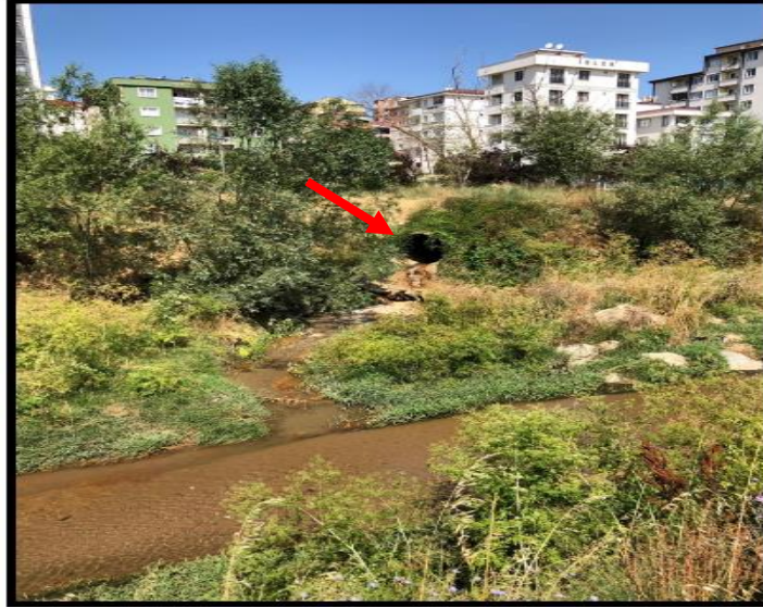
Şekil 4.14: Saz Deresi'nde taşkın bölgesindeki yapılar ve deşarj noktası.
