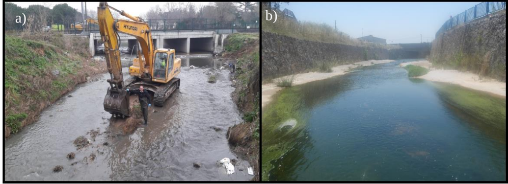
Şekil 4.11: Saz Deresi'nde a) SD-0-1 noktasında nehir kenar materyali yapım aşaması ve b) SD-0-6 noktasının devamında nehir kenar materyali.
