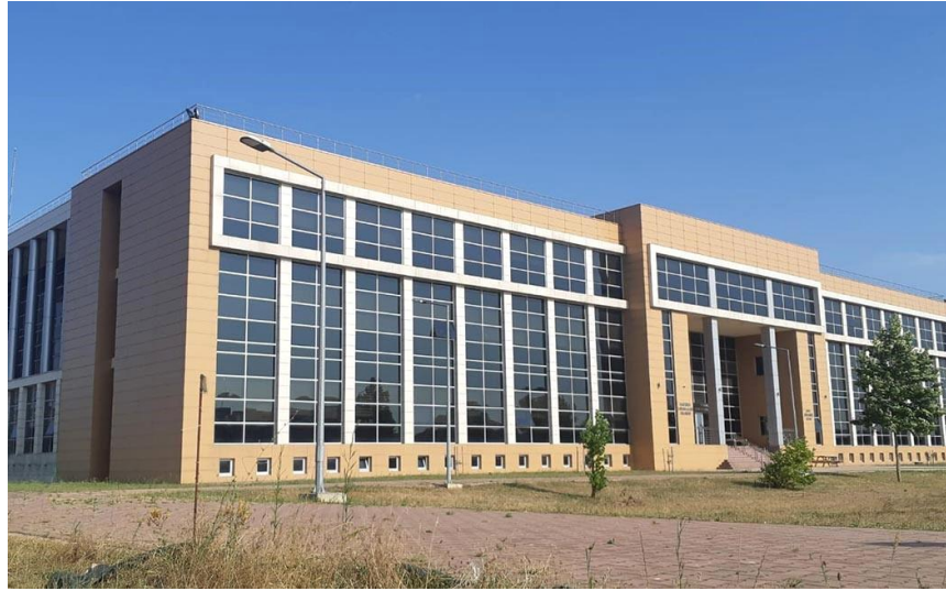
Şekil 3.5: Çevre-Kimya I2 Blok Binasına ait bir fotoğraf [Web 15, 2025].
