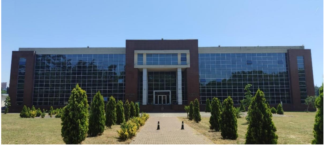
Şekil 3.7: Malzeme Bilimi ve Mühendisliği H2 Blok Binasına ait bir fotoğraf [Web 16, 2025].
