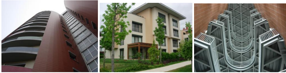
Şekil 5.5. Yerleşimdeki betonarme ve çelik konstrüksiyonlu binalar (İnternet, 63 )
