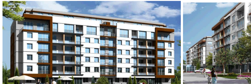
Şekil 5.38. Yerleşimde bulunan konut bloklarının dış cephelerinden bir görünüş
