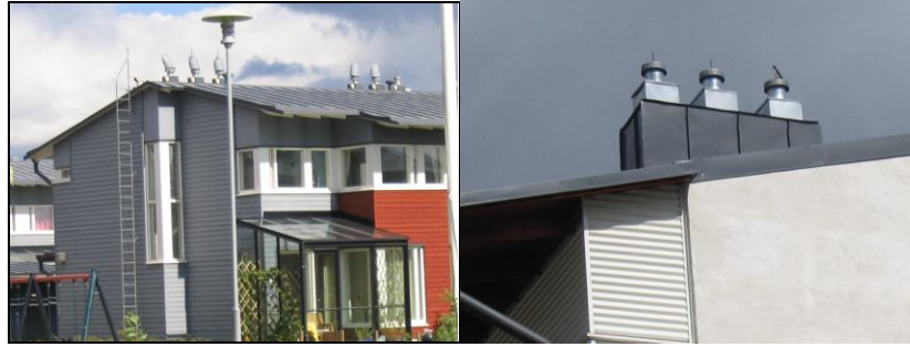
Şekil 4.13. Kış bahçesi ve bacalardaki negatif basınç fanlarından görünüş (Viikki, 2002).
