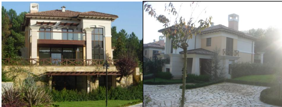
Şekil 5.43. Yerleşimde bulunan konut bloklarının dış cephelerinden bir görünüş
