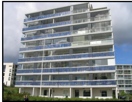
Şekil 4.12. Balkon parapetlerinde güneş panellerinden görünüş (Viikki, Guide, 2004).
