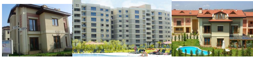
Şekil 5.34. Yerleşimdeki betonarme binalar
