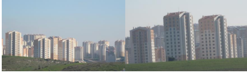
Şekil 5.21. Yerleşimdeki konut birimleri dış cephelerinden görünüşler
